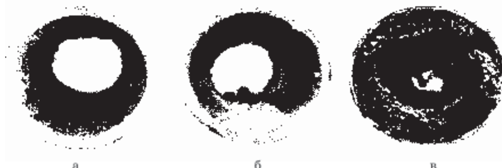
Рис. 1. Коррозионное зарастание труб после 5, 7, 10 лет (соответственно а, б, в) эксплуатации на Воронежском водопроводе (по В. И. Щербакову)
