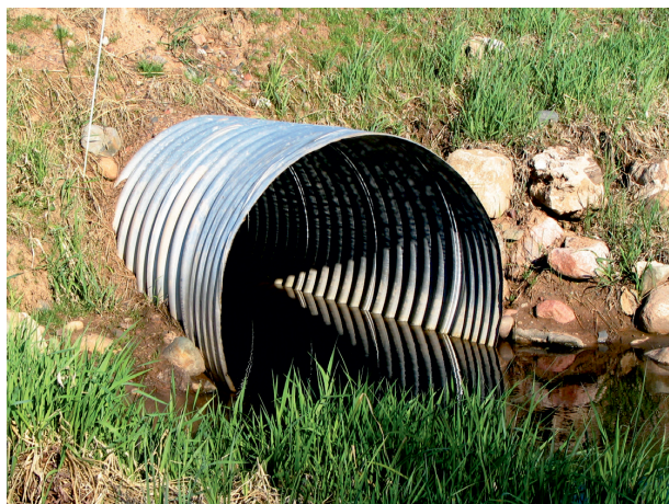
Рис. 1. Водопропускное сооружение из металлической гофрированной трубы без оголовка со спиральной формой гофра
