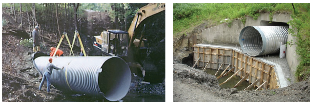
Рис. 1. Автомобильный трубчатый переход на водотоке в процессе релининга
