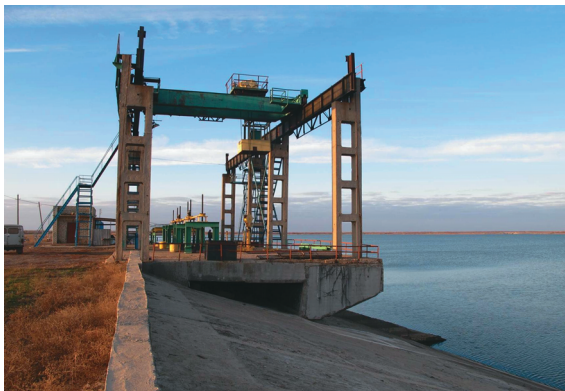
Рис. 2. Водосброс верхнего бьефа Верхнеперекопновского водохранилища на р. Малый Узень Ершовского района Саратовской области. 2013 г.
