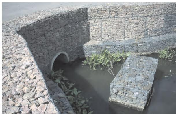
Рис. 1. Устройство нижнего бьефа металлических гофрированных труб с гасителями энергии из габионов на обьездной дороге в городе Коломне (2012 год)
