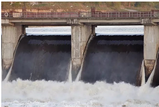
Рис. 1. Фото перелива воды через гребень криволинейного водослива
