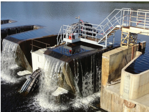
Рис. 3. Опытная микро-ГЭС с ортогональной турбиной в качестве рабочего агрегата на Хоробровском гидроузле
