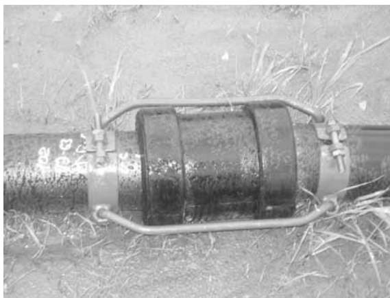
Рис. 3. Соединение труб в муфте
