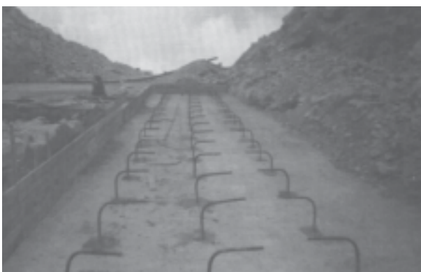
Рис. 3. Установка анкеров
