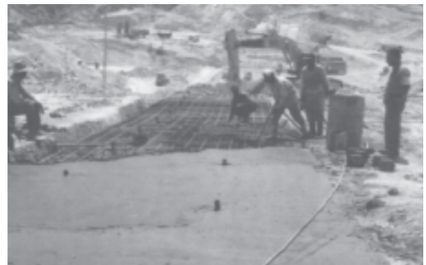
Рис. 5. Бетонирование плиты
