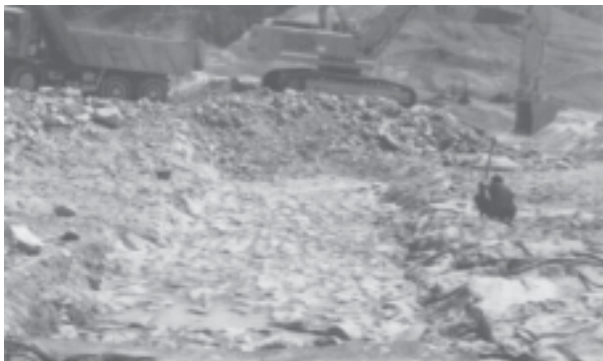
Рис. 1. Разработка основания под цементационную плиту
