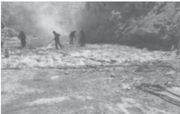
Рис. 2. Подготовка основания под цементационную плиту
