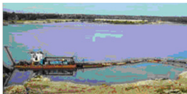
Рис. 3. Рабочий этап возведения защитной дамбы с одновременной разработкой донных отложений: а – разработка донных отложений; б – возведение защитной дамбы с использованием распределительного устройства
