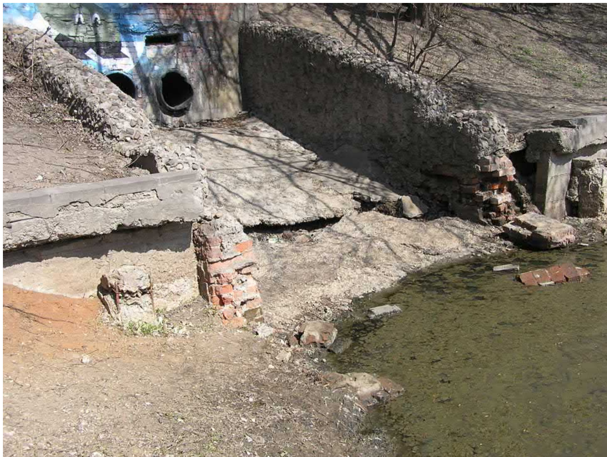
Рис. 1. Выходной оголовок двухочкового нерегулируемого аварийного водосбросоводовыпуска из Среднего Красногвардейского пруда в Нижний Красногвардейский пруд, Пресненский район, ЦАО Москвы, река Студенец, апрель 2014 го
