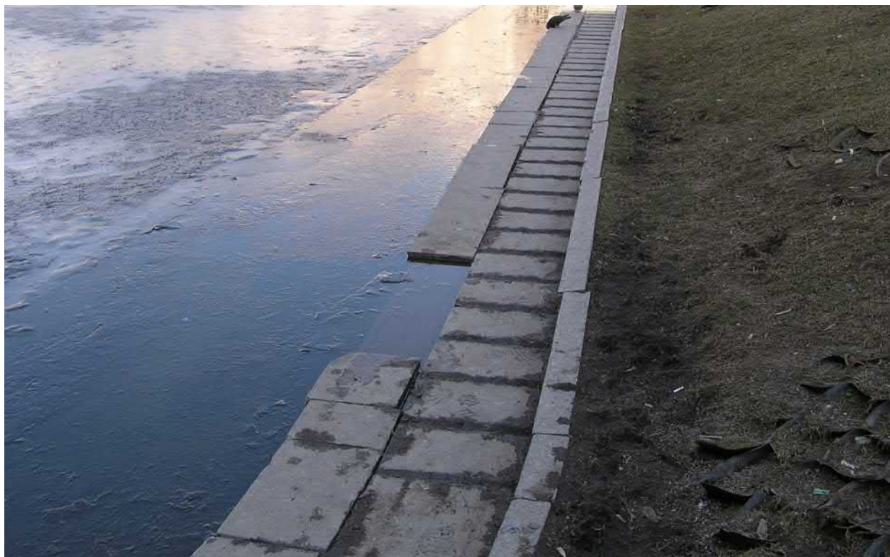
Рис. 2. Состояние берегоукрепления и бермы первого яруса Патриаршего пруда, муниципальное образование Пресненское, ЦАО Москвы, апрель 2014 год
