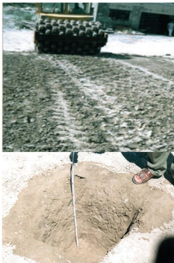
Рис. 2. Устройство опытной насыпи из продуктов разрушения мергеля
