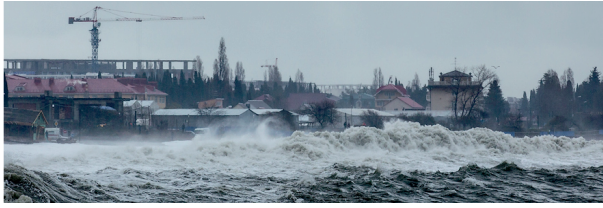
Рис. 2. Накат волн на берег и берегозащитное сооружение в зоне каньона Нового в шторме (24 марта 2013 года)
