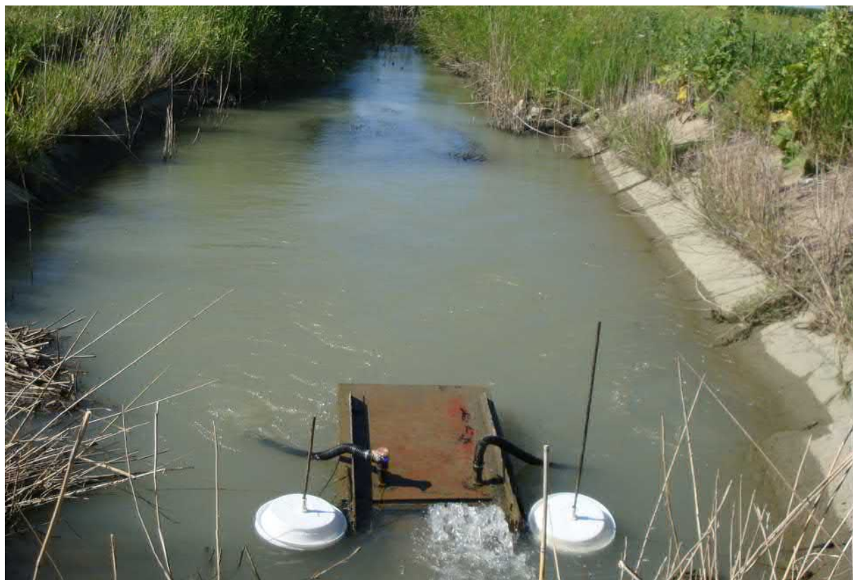
Рис. 5. Работа канального регулятора CLC-6-AB в голове распределителя модуля системы «кубанского» типа
