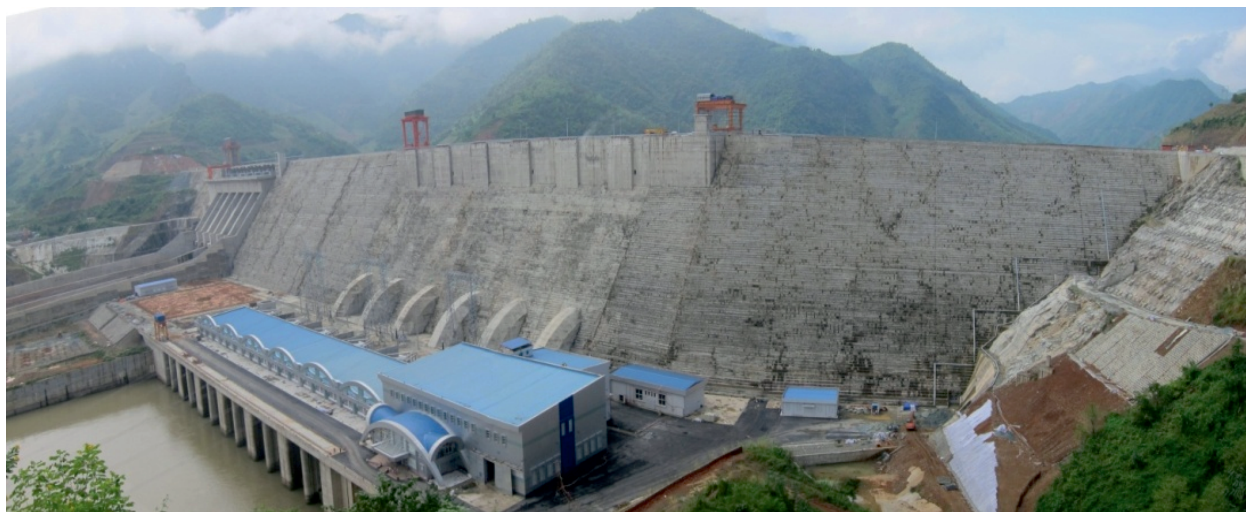
Рис. 1. Сооружения напорного фронта. Вид с нижнего бьефа
