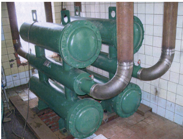
Рис. 1. Стабилизатор давления «ЭКОВЭЙВ» СДТ 16-150
