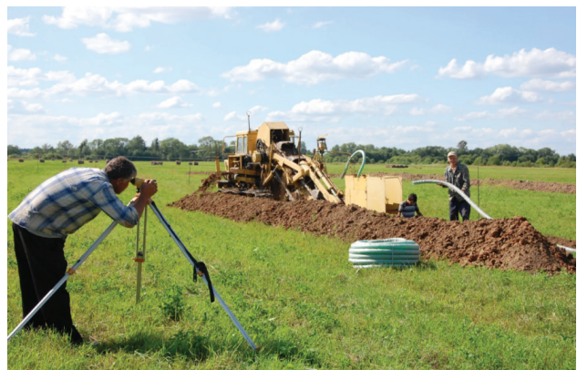
Рис. 3. Строительство закрытой осушительной сети
