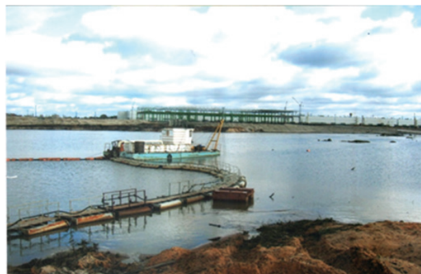
Разработка земснарядом донных отложений
