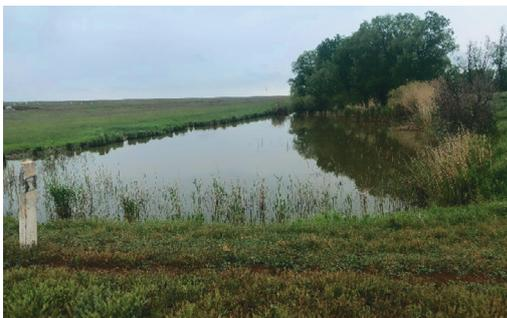
**Рис. 2. Участок подтопления приканальной территории фильтрационными водами из канала ВР-1 на ПК332+00**
