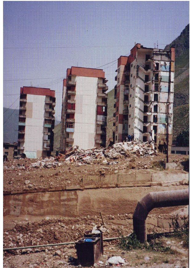
Рис. 4. Вогнутый береговой участок селевого русла реки Герхожан-су с очень высоким уровнем селеопасности. Разрушенный девятиэтажный дом при выходе (на повороте) селевых масс с валунами из русла водотока (июль 2000 года, город Тырнауз, Кабардино-Балкария)
