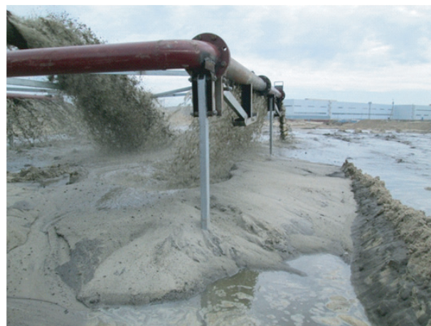
Рис. 4. Опытный намыв фрагмента защитной дамбы
