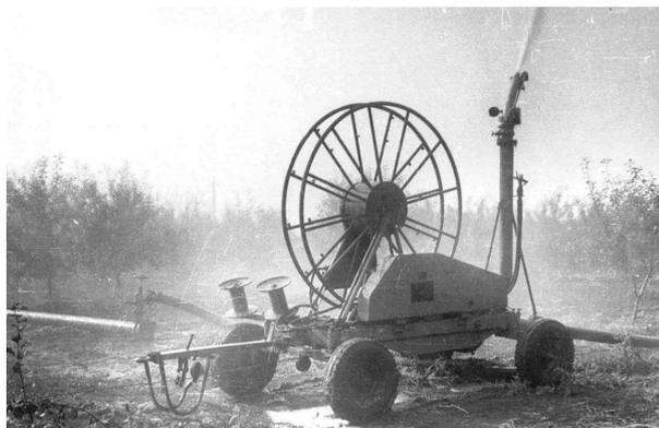
Рис. 2. Шланговый дождевательный агрегат ДДС-30
