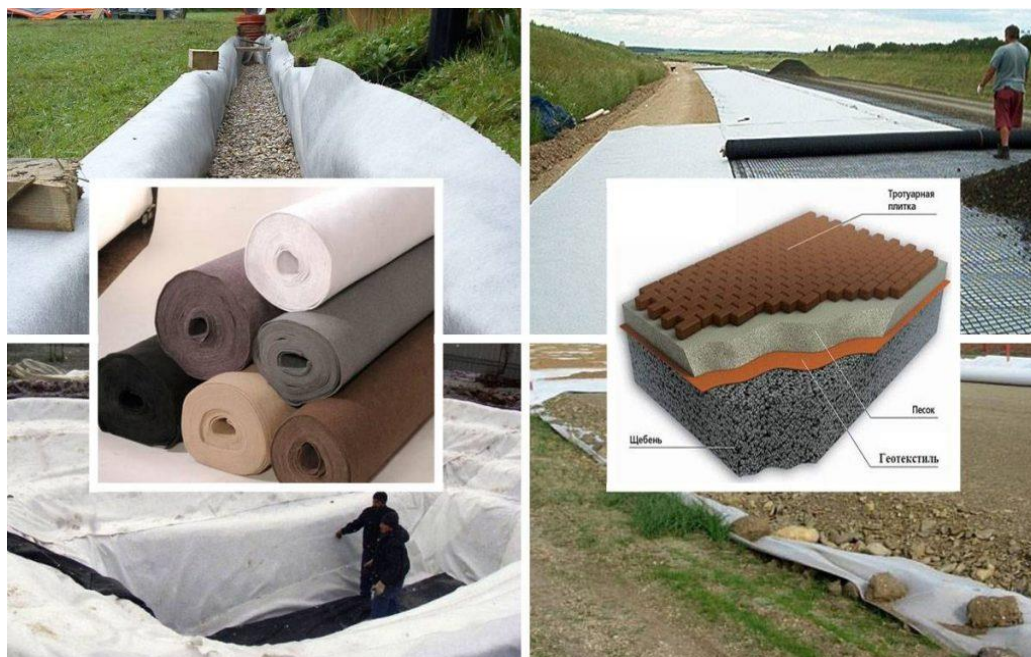
Рисунок 16.15. - Геотекстили и примеры их применения
