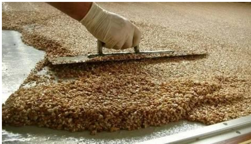
Рисунок 16.17. - Укладка мощения из мелкого гравия на связующей смоле ЮниМакс
