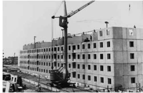
Строительство пятиэтажного жилого дома. Город Волжский
