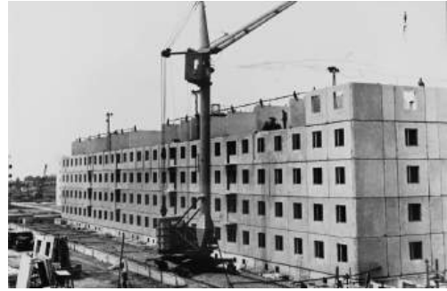
Строительство пятиэтажного жилого дома. Город Волжский
