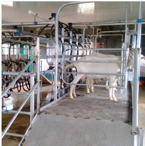
Рисунок 61 – Доильная установка типа «Параллель» на эстакаде: А) – с боковым выходом, Б) – с быстрым выходом.
