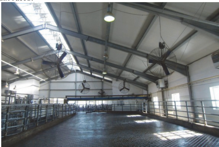
Рис. 14.8. Вентиляторы, расположенные в два ряда
