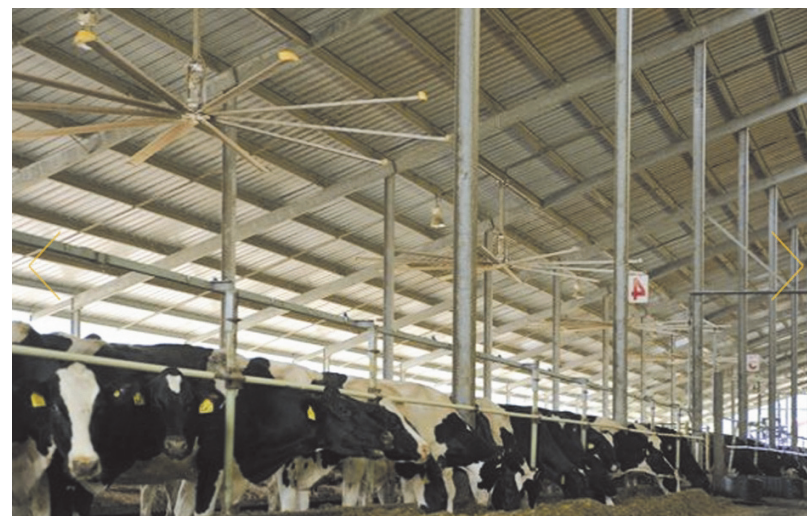
Рис. 14.2. Потолочные вентиляторы над кормонавозным проходом
