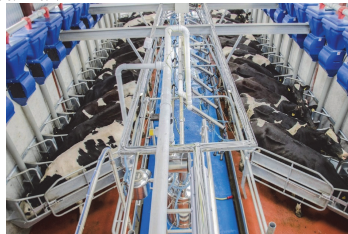
Рис. 6.1. Автоматизированная доильная установка «Ёлочка»
