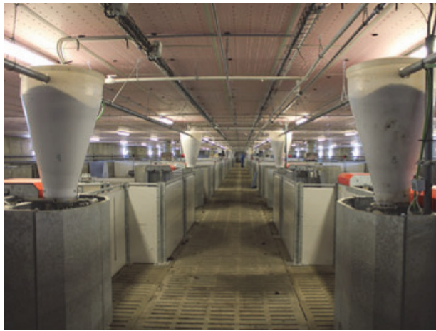
Рис. 9.4. Транспортировка комбикорма в автоматические кормовые станции
