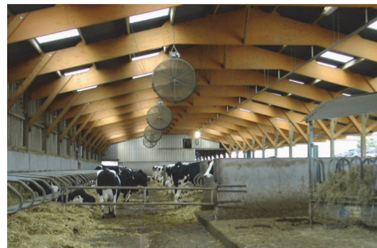
Рис. 14.3. Наклонные вентиляторы над навозным проходом
