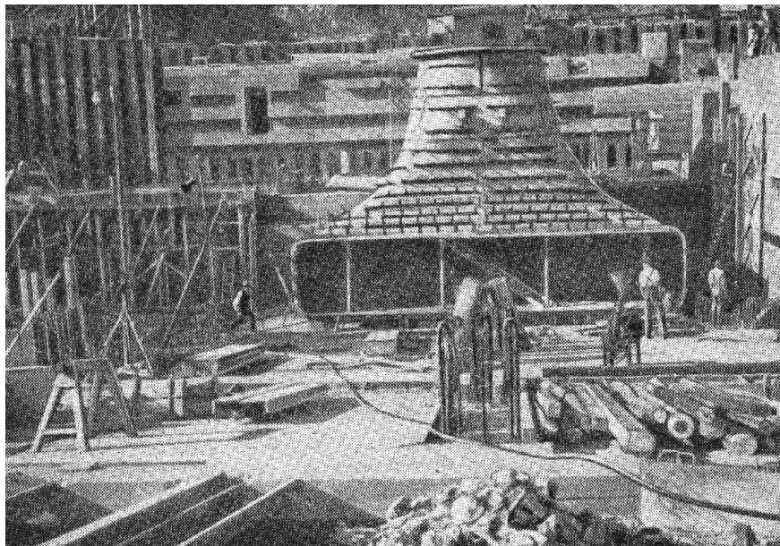
Рисунок 4.10 – Металлическая опалубка изогнутой отсасывающей трубы
