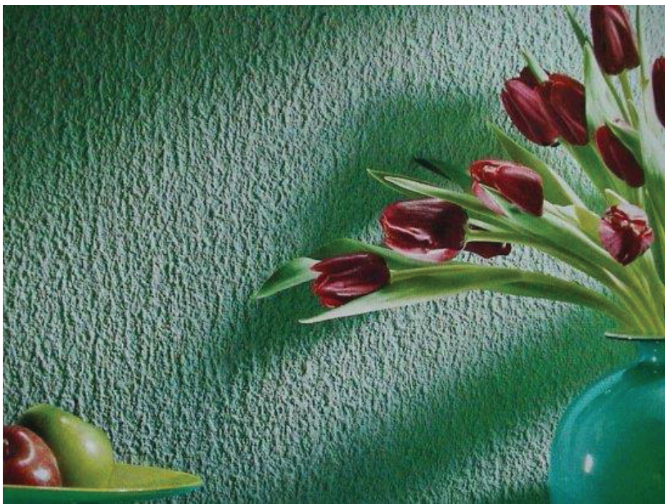
Рисунок 4.4 – Структурная штукатурка
