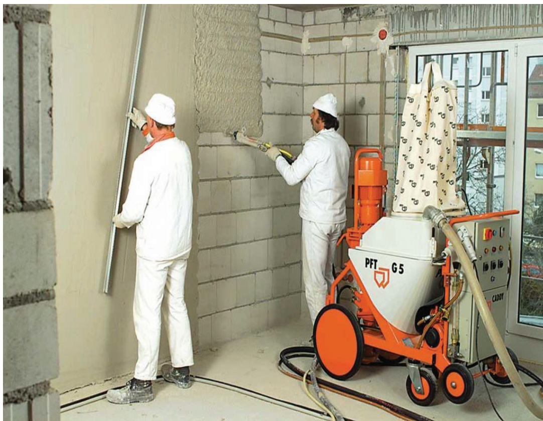
Рисунок 4.3 – Производство штукатурных работ
