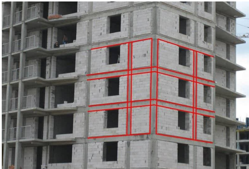
Рисунок 8.7 – Панели стен жилого дома из силикатного бетона
