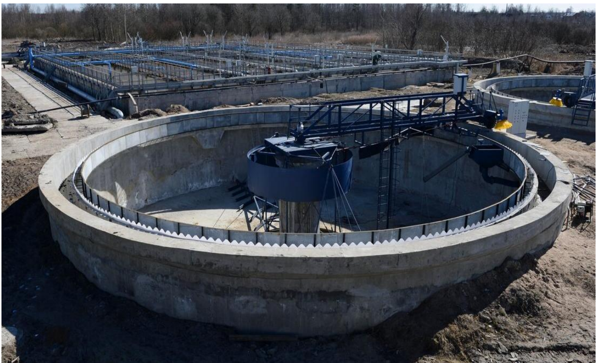
Рисунок 7.6 – Отстойник из монолитного железобетона
