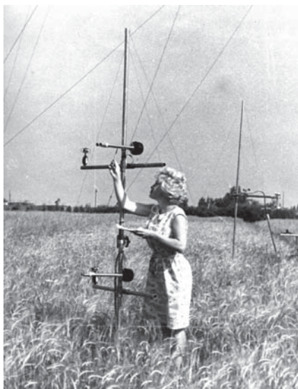
Рис. 16.6. Производство микроклиматических градиентных наблюдений (измерений) на посевах ярового ячменя
