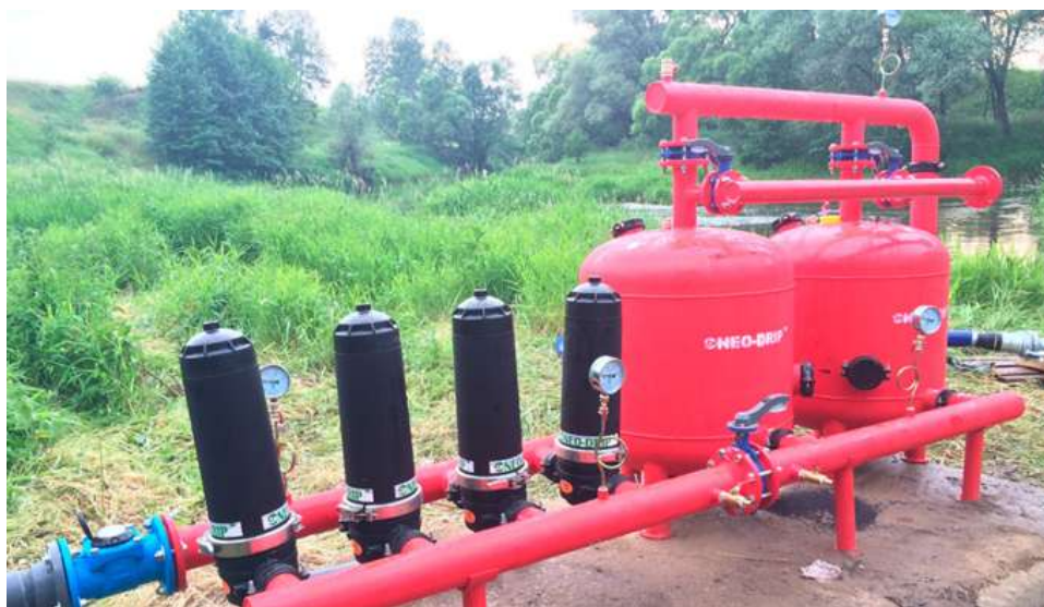
Рис. 359. Фильтровальная станция
