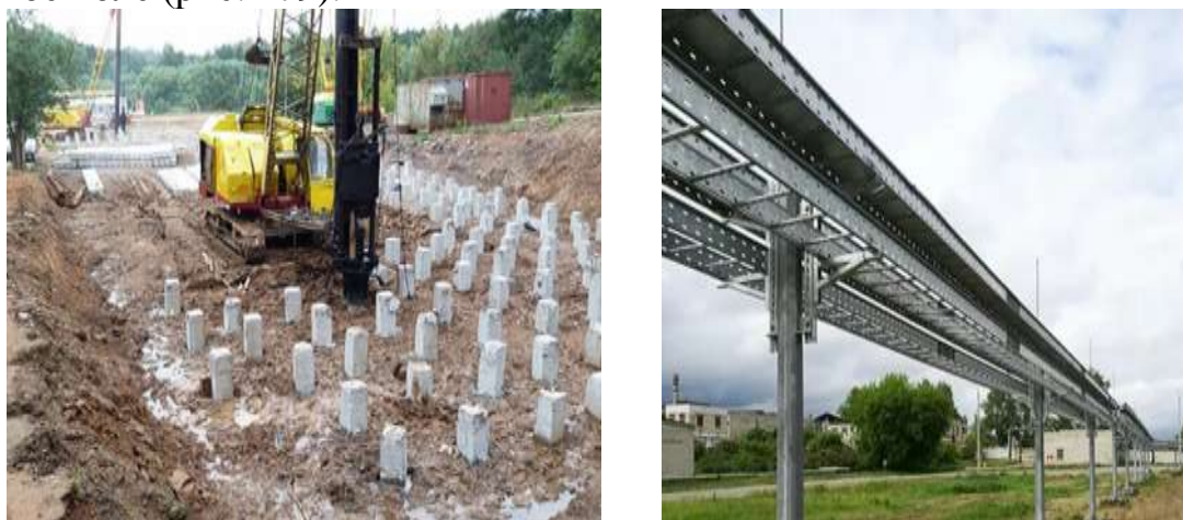
Рис. 179. Установка свайных опор
