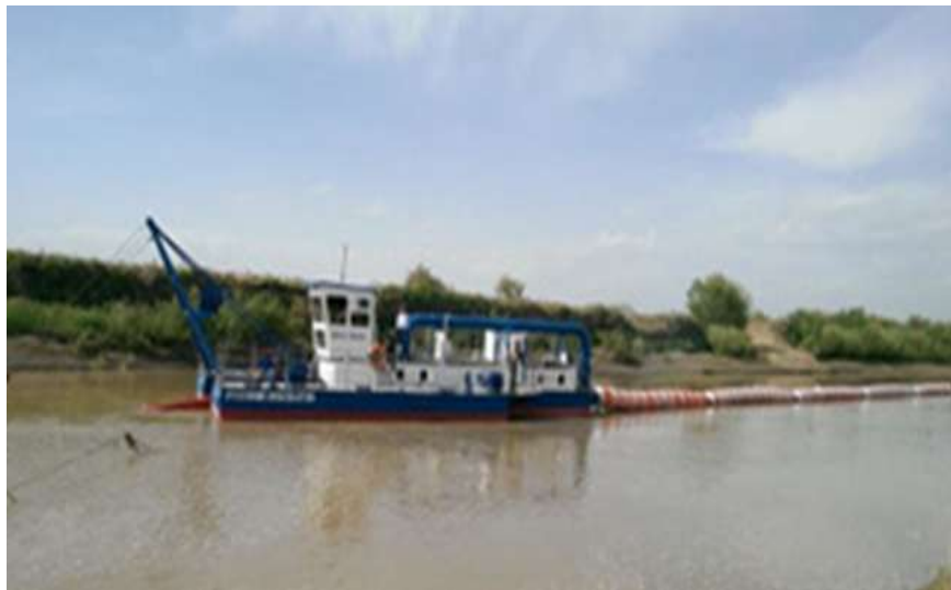
Рис. 169. Очистка реки земснарядом
