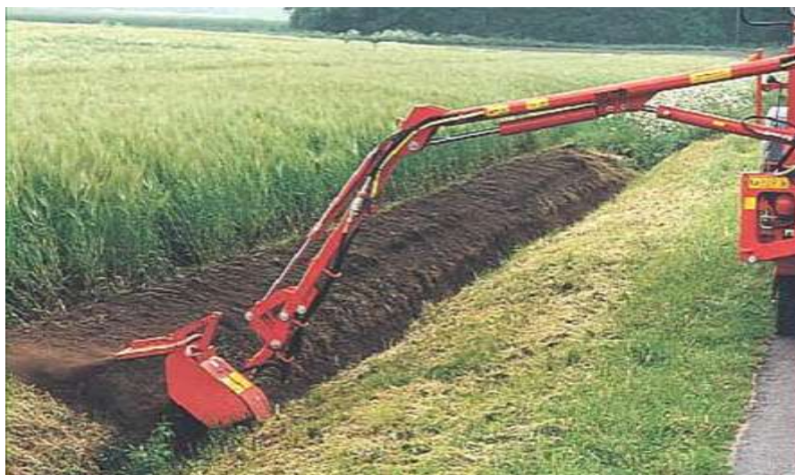
Рис. 273. Процесс очистки канала фрезерным рабочим органом
