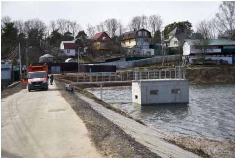
Рис. 1.6. Восстановленные ГТС плотины на р. Синичка, М.О., 2019 г.
