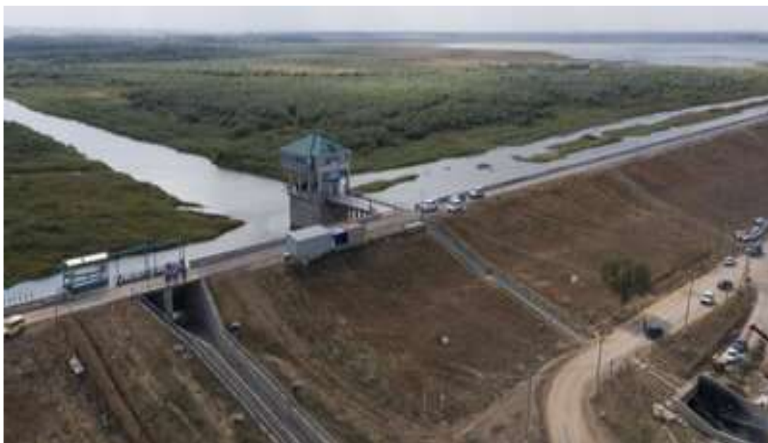
Рис. 3.1. Вид со стороны нижнего бьефа на реконструируемый (2019 г.) гидрокомплекс Отказненского водохранилища на р. Куме с волноотбойной стенкой в пригребневой части верхового откоса и новым резервным открытым береговым водосбросом
