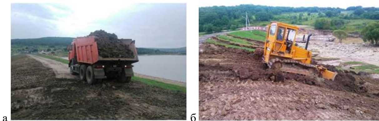
Рис. 4.3. Ремонт водохранилищ Уссурийска после тайфуна Гони, 2015 г.
