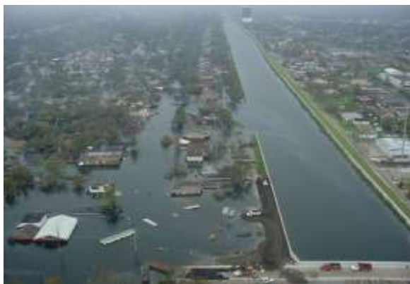
Рис. 2.1. Разрушение плотины и оползение на 80% г. Новый Орлеан (США) в результате урагана «Катрина», 2005 г.
