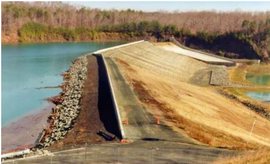
Рис. 3.7. Вид с правого берега на гидроузел Смит Лейк после реконструкции
