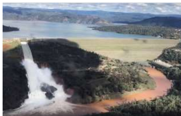
Рис.2.2. Авария на открытом водосбросе плотины Оровил, США, Нпл= 235 м, 2017 г.
