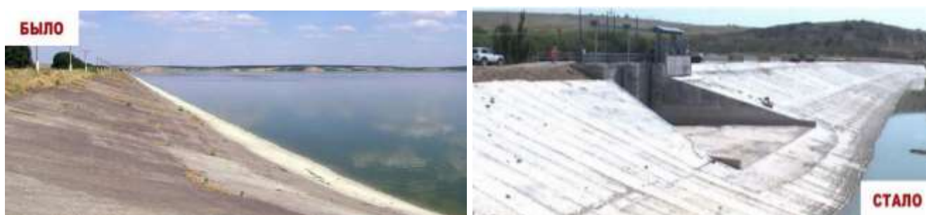
Рис. 3.3. Правобережный участок Отказненской плотины
