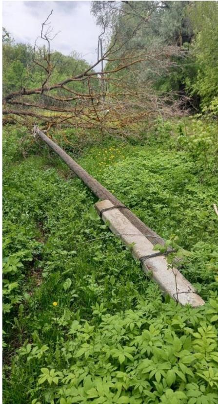
**Рис. 1 Разрушение опоры ВЛЭП упавшим деревом**
