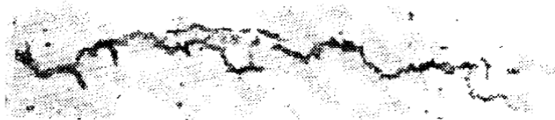
Рисунок 3 – Один из видов микротрещин в бетонных конструкциях
