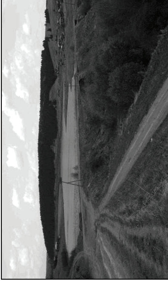
Рис. П1.13. Общий вид завода Молѣбка на р. Молебной с водяными колёсами (плотина высотой 10,5 м и длиной более 200м возведена в 1775 г., домна, две фабрики, пыльная, мушная однопоставная водяная мельница, кузница и др.), принадлежажавшего династии Демидовых в Пермской губернии: а - рисунок конца XIX в.; б – современное состояние плотины завода
