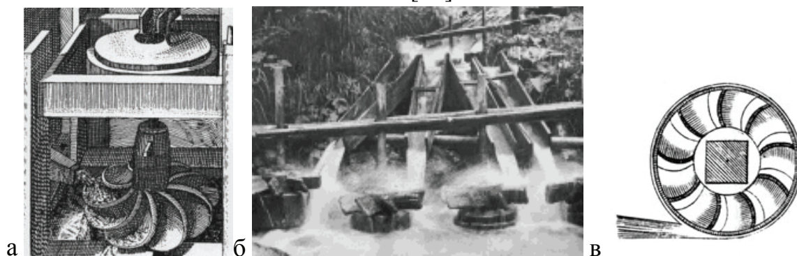
Рис. 3.18. Водяное колесо с вертикальной осью: а – созданное в XVI в., используемое позднее Д. Бранка, а затем Я. Страда для рециркуляционной мельницы; б - использование колёс вплоть до XX в. в австрийских Альпах для шлифования мрамора; в – вид сверху «турбинного» колеса в ванне, середина XIX в.
