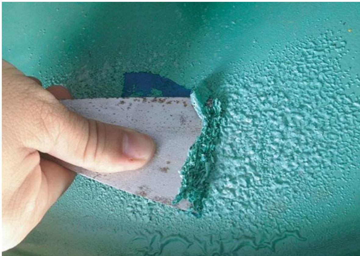
Рис. 1. снятие ЛКП шпателем после нанесения на него средства для удаления краски
