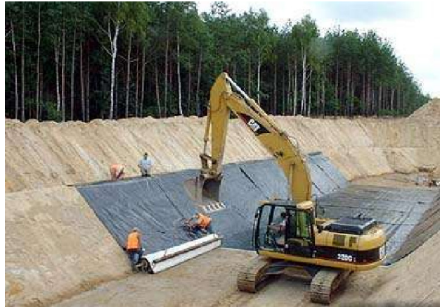
Рисунок 5.5 – Гидроизоляция канала бентонитовыми матами
