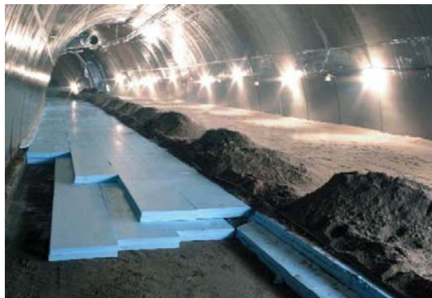
Рисунок 5.3 – Гидроизоляция тоннеля
