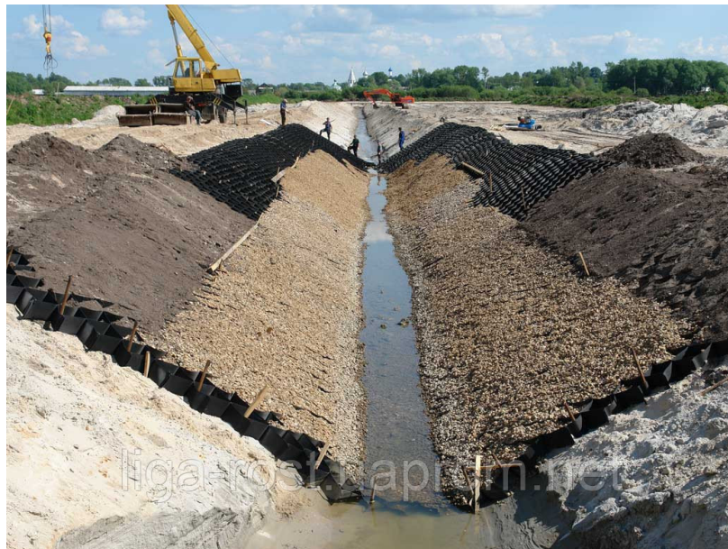
Рисунок 7.2 – Применение георешетки для закрепления откосов канала
