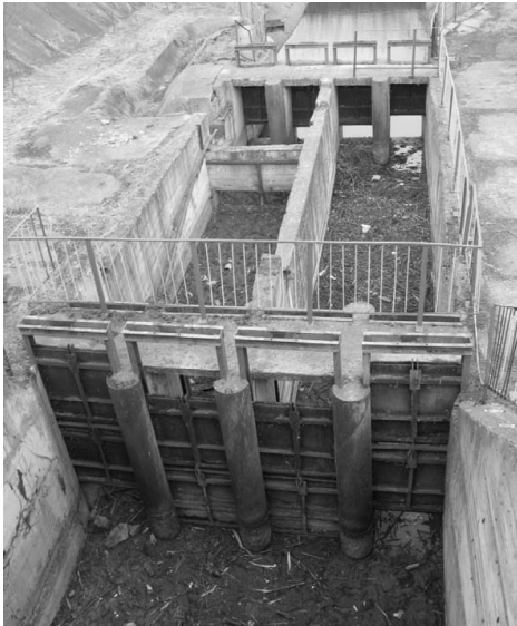
Рисунок 2.12 – Состояние концентратора сора РЗС ДМК
