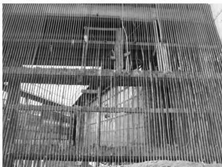
Рисунок 2.8 – Состояние сороудерживающей решётки РЗС ДМК
