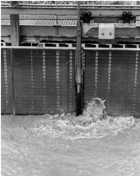
Рисунок 3.8 – Плоский экран РЗС и щёточный очиститель с подачей воздуха в нижнюю часть щёткодержателя (р. Якима, США)
