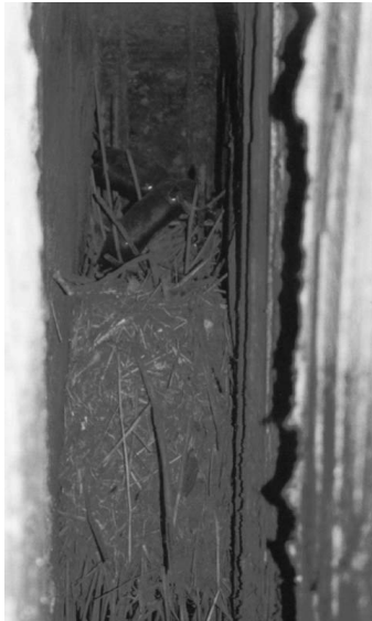
Рисунок 2.10 – Вид со стороны приёмного окна на распределительный профиль, забитый тростником, пластиковыми бутылками и др.
