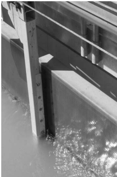
Рисунок 3.7 – Щеточный очиститель защитного экрана (р. Хук, США)
