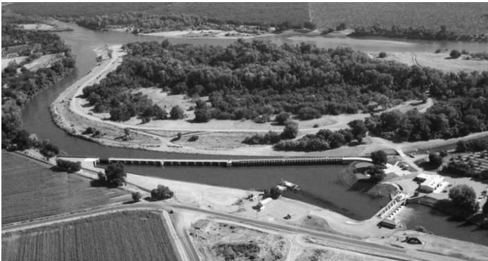
Рисунок 3.16 – Общий вид на водозаборное сооружение GCID [106]
