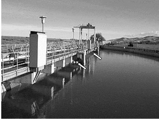
Рисунок 3.14 – Общий вид на рыбозащитное сооружение канала Чандлер (стрелками показаны промежуточные входы в рыбоотвод)
