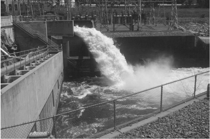
Рисунок 5.3 – Свободное падение потока рыбоотвода в нижний бьеф ГЭС Bellows Falls (р. Коннектикут, США) [101]
