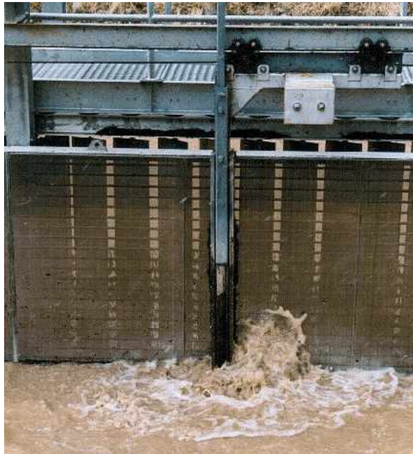
Рисунок 1.9 – Щёточный очиститель плоского экрана с подачей воздуха в нижнюю часть щёткодержателя (р. Якима, США)
