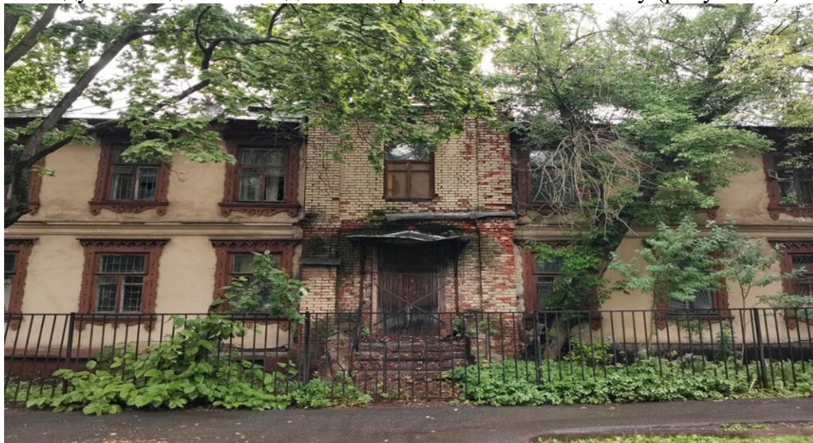
Рисунок 1 – Главный фасад здания
