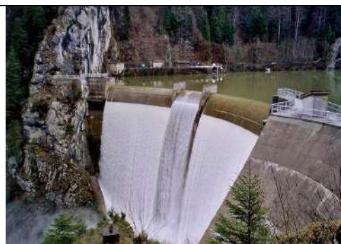
Рис. 3.44. Плотина Chatelot (Швейцария): высота плотины 74 м, длина по гребню 150 м, расход водосброса 500 м 3 /с, 1953 г.
