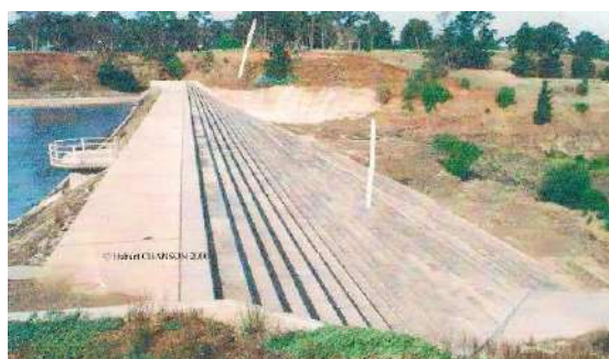
Рис. 4.17. Пример грунтовой водосливной плотины со ступенчатой водосливной поверхностью
