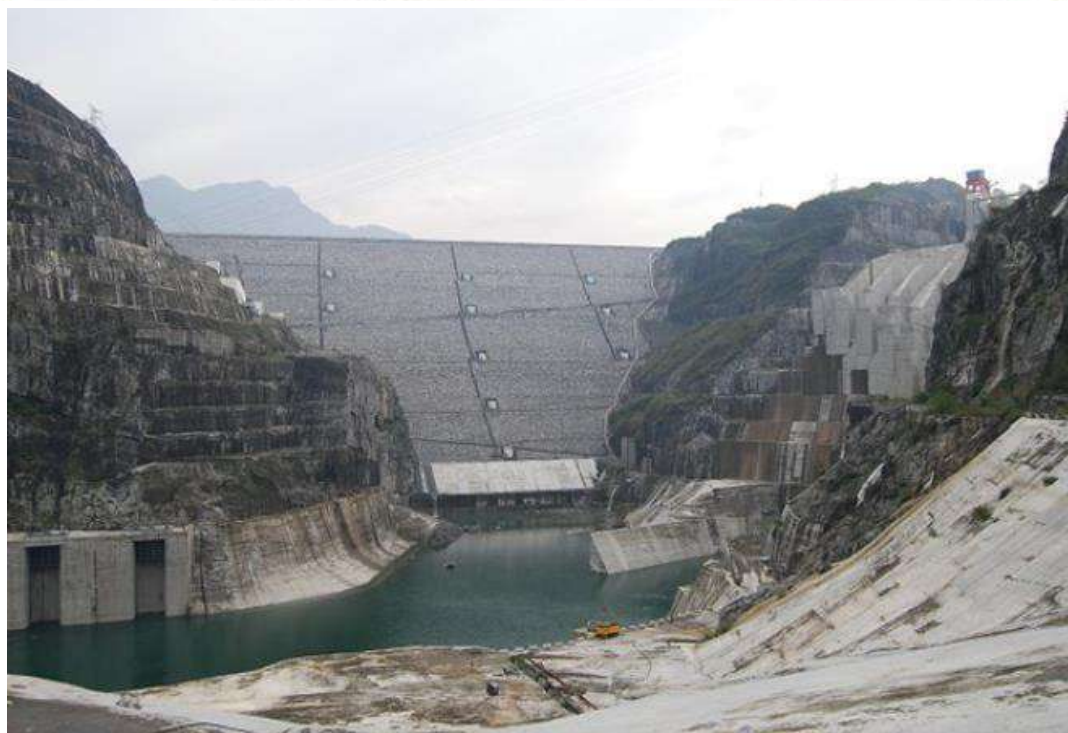
Рис. ПЗ.12. Вид с нижнего бьефа на гидроузел Шуйбуйя: а – проектный вариант; б – после строительства. Поверочный расход 5-ти пролётного водосброса 18\,320\text{ м}^3/\text{с} . Расход одноочкового подземного водовыпуска 1605\text{ м}^3/\text{с}
