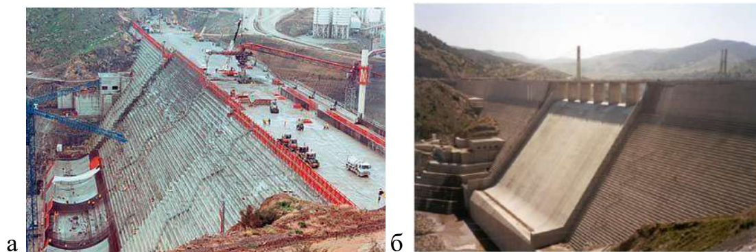
Рис. 3.32. Плотина Бени Харун: а - в период строительства; б - вид построенной плотины, низовая грань глухой части ступенчатая, водосливная поверхность гладкая
