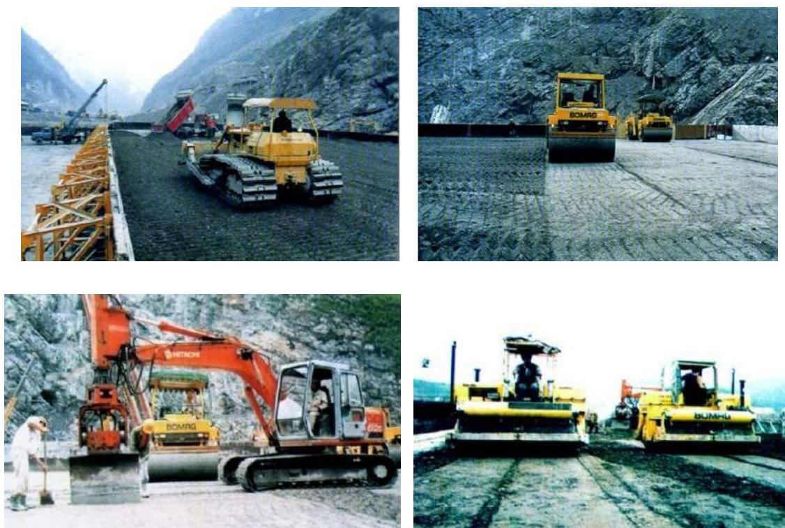
Рис. 3.33. Примеры, иллюстрирующие процесс строительства плотин из укатанного бетона (КНР)
