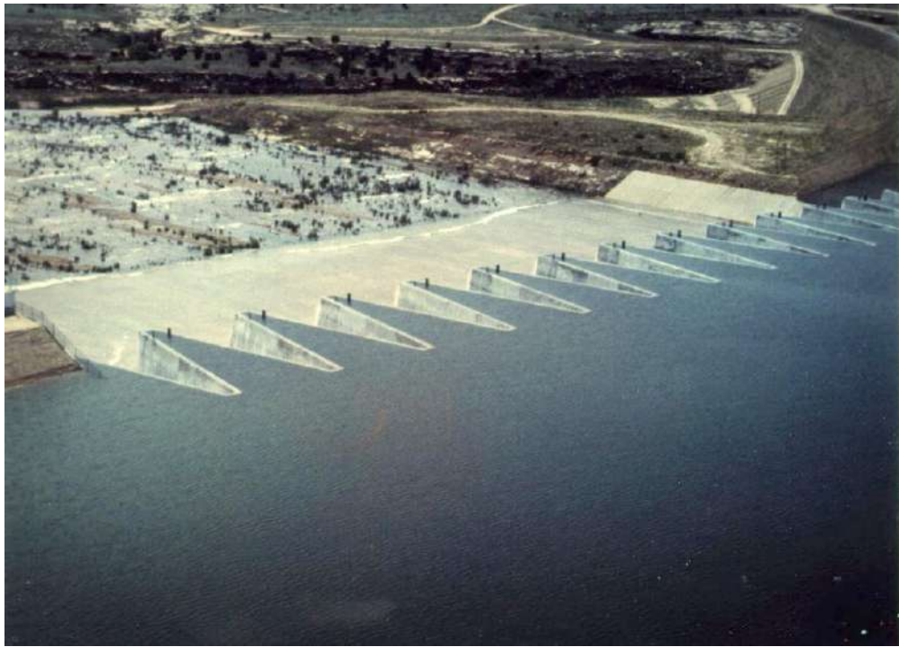
Рис. 4.8. Лабиринтный водослив в гидроузле UteDam, штат Нью Мексико (США)
