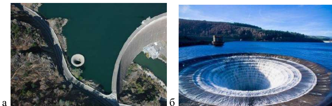
Рис. 4.35. Шахтный водосброс гидроузла Монтичелло (США) (а) и ступенчатый шахтный водосброс Ladybower (Англия) (б)
