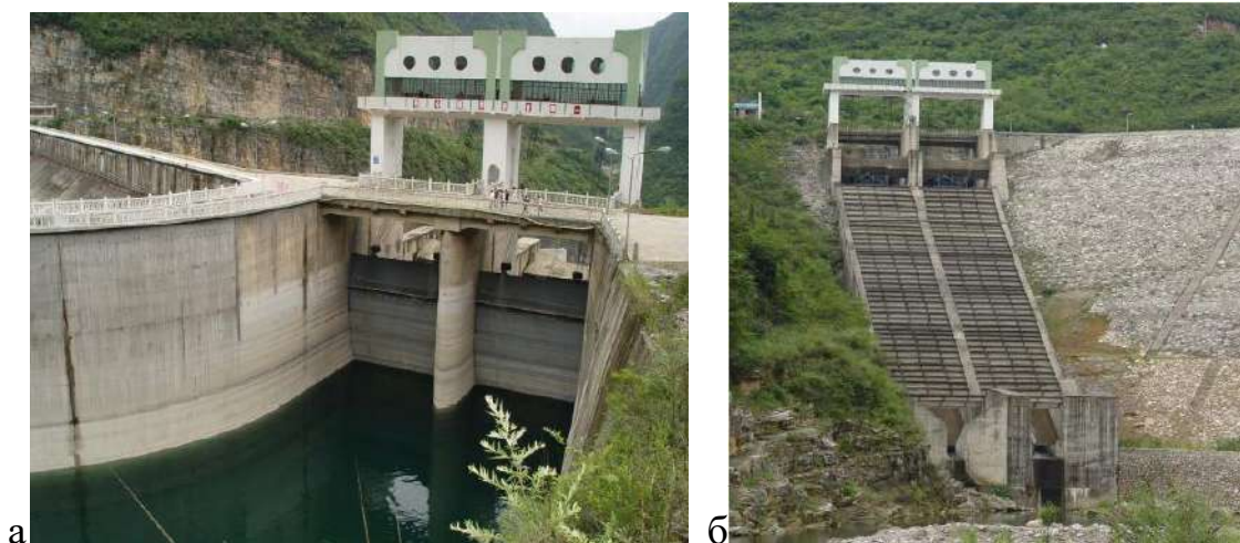
Рис. 4.10. Вид на головную часть берегового водосброса с верхнего (а) и нижнего бьефа (б), КНР
