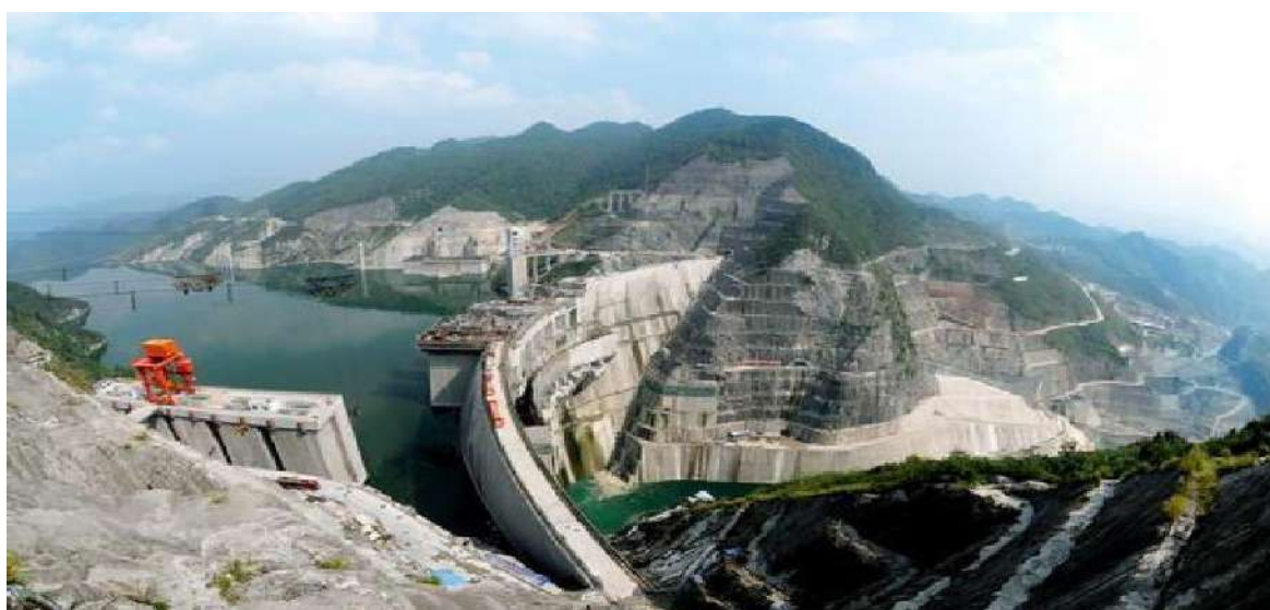
Рис. ПЗ.5. Вид на плотину Дахуашуй со стороны нижнего бьефа
