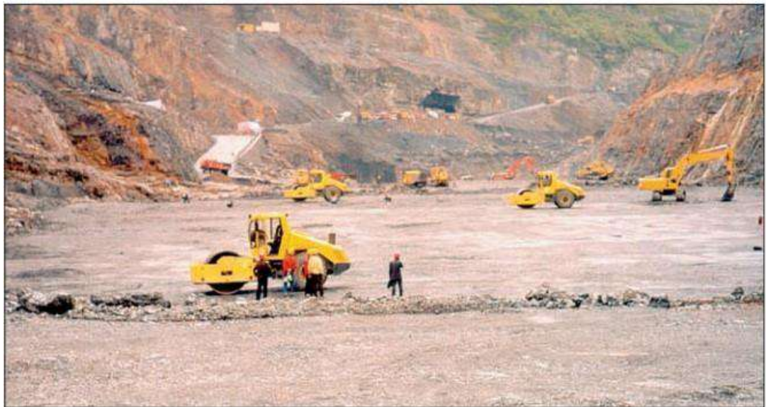
Рис. ПЗ.13. Схема (а), конструкция (б) и строительство (в) каменно-набросной плотины гидроузла Шуйбуй высотой 233 м, длина по гребню – 409 м
