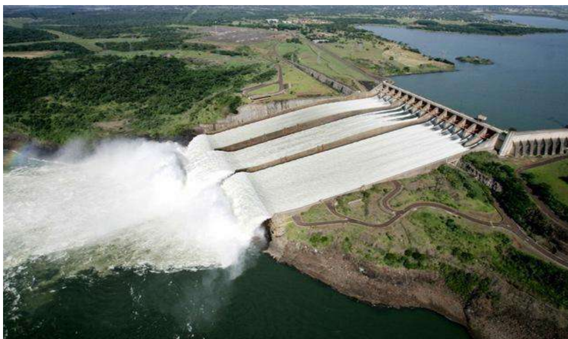
Рис. 4.24. Береговой поверхностный водосброс гидроузла Итайпу (Бразилия), сопряжение бьефов с отбросом струи
