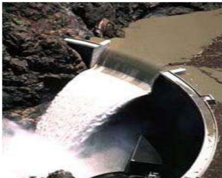
Рис. 4.66. Арочная плотина Crystal (США) с нерегулируемой водобросной частью в виде водослива практического профиля
