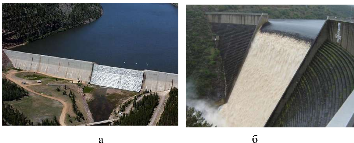
Рис. 4.68. Плотины из укатанного бетона со ступенчатой водосливной гранью: а - UpperStillwater, США, 1983 - 1987 гг.; б – Wolwedans, Южная Африка, высота плотины 70 м, 1990 г.
