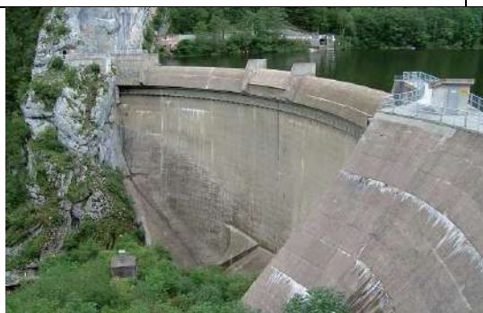
Рис. 3.44. Плотина Chatelot (Швейцария): высота плотины 74 м, длина по гребню 150 м, расход водосброса 500 м 3 /с, 1953 г.
