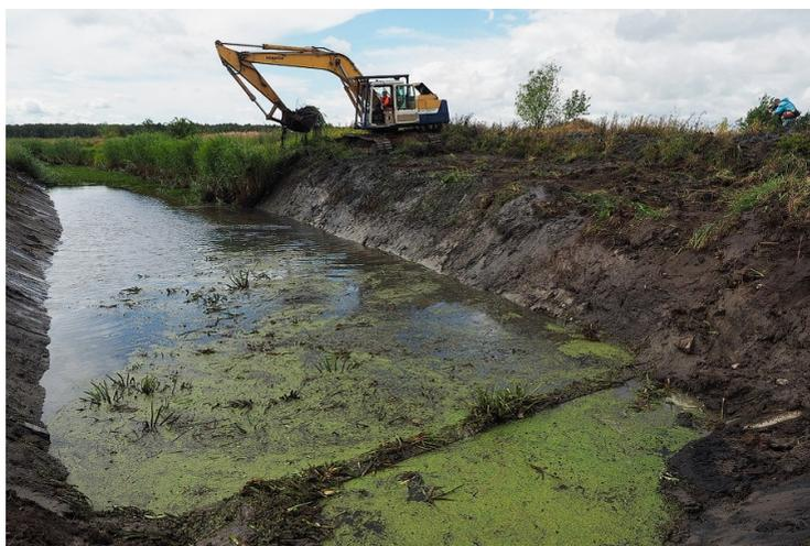
Рисунок 1.5 – Эксплуатационное мероприятие очистка канала от наносов и зарастания экскаватором.
