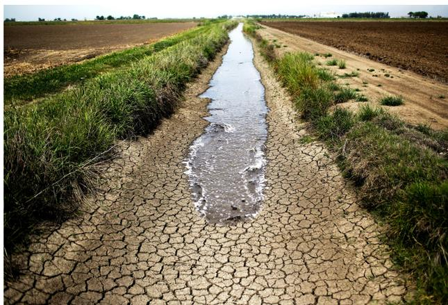
Рисунок 1.6 – Фильтрация воды в грунтовое ложе канала.
