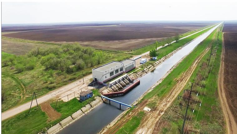
Рисунок 3 - Оросительный канал с насосной станцией для внутрихозяйственной системы.
