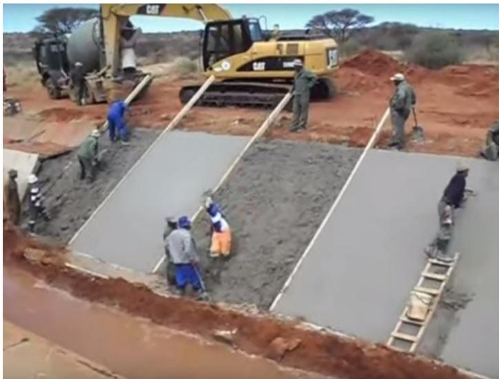
Рисунок 1.10. - Бетонная облицовка ложа оросительного канала.
