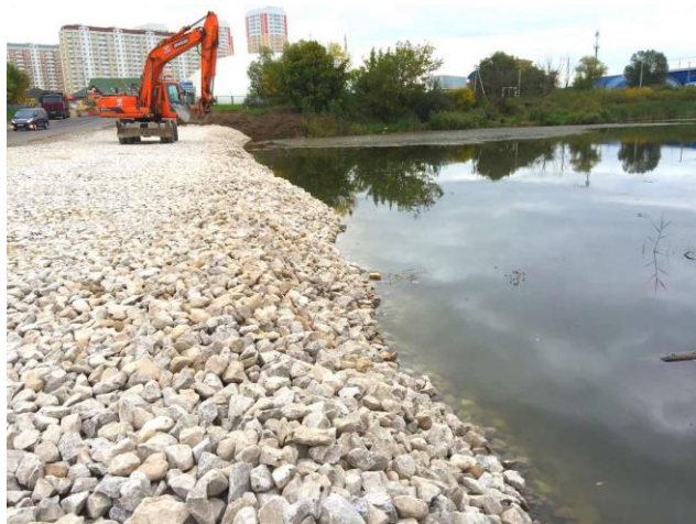
Рис. 2.16. Крепление откоса каменной наброской
