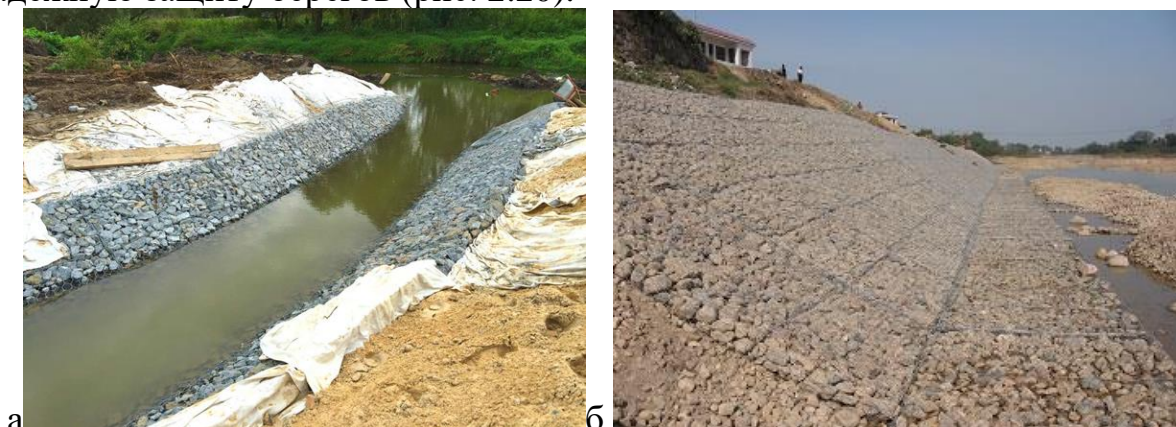
Рис. 2.20. Крепление откоса матрасами Рено: а – водотока, впадающего в водохранилище; б – водоёма (во время реконструкции)
