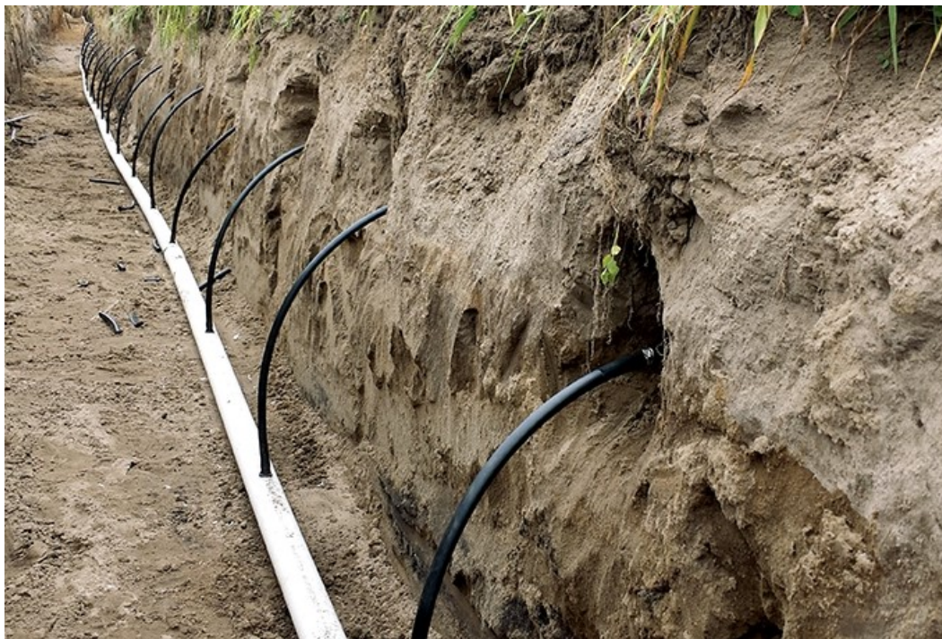
Рисунок – 1.14 Подпочвенное орошение при подаче стоков по трубопроводам к оросительной сети.
