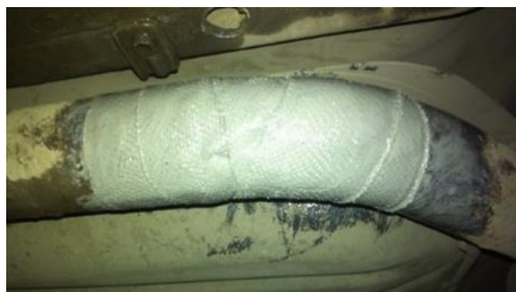
Рис. 1. Установка бандаж на поврежденный участок трубы.
