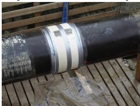
Рис. 2. Пример установки муфты на поврежденный участок трубопровода
