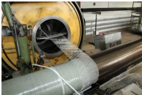
Рис. 3. Ремонт труб с применением ПКМ (способ намотки ткани, пропитанной связующим).
