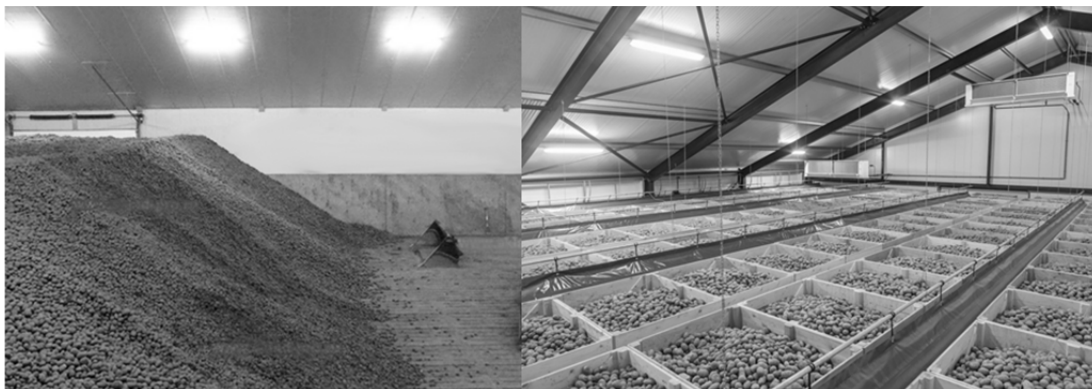
Рисунок 1 – Картофелехранилище навалного и контейнерного типа хранения
