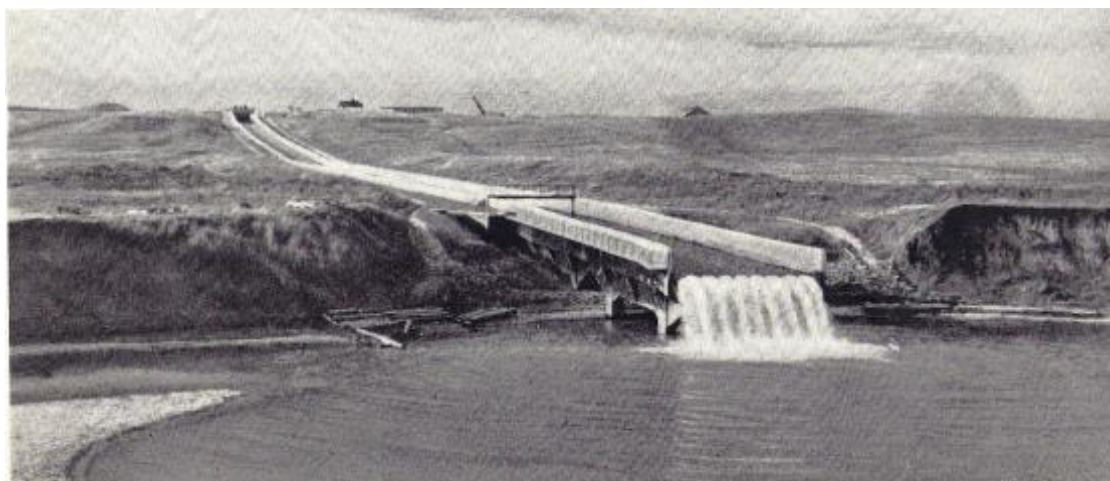
Рисунок 1.1. Общий вид конечного участка быстротока, выполненного в виде консольного водосброса
