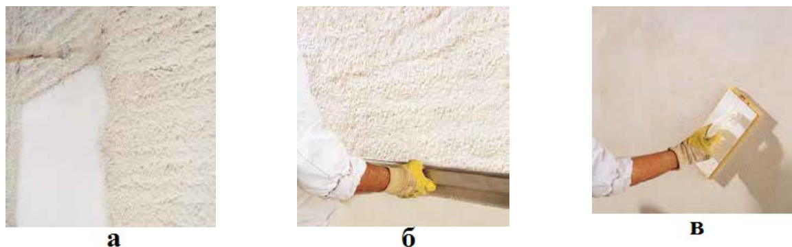
Рис. 3.87. Наружное оштукатуривание: а — нанесение штукатурки; б — выравнивание; в — затирка
