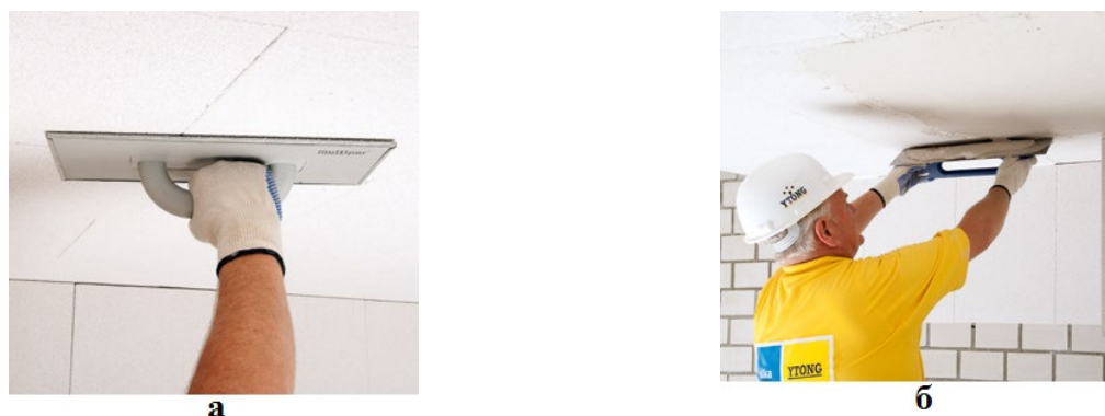
Рис. 4.90. Простая шлифовка (а) и нанесение легкого раствора Multipor (б)
