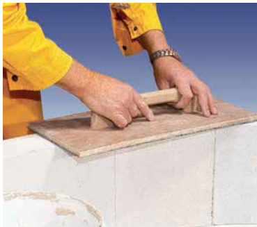
Рис. 3.77. Укладка дугообразных блоков: а — укладка первого ряда дугообразных блоков; б — армирование горизонтальных швов; в — о поверхности кладки шлифовальной доской; г — изготовление каналов для прокладки электропроводки
