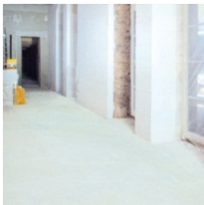
Рис. 4.11. Изоляция стен помещения
