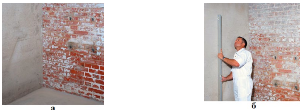
Рис. 4.55. Подготовка поверхности: а — старая стена; б — оценка ровности поверхности основы
