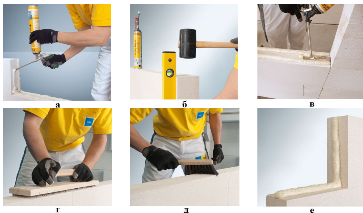
Рис. 3.90. Укладка второго слоя: а — вертикальный шов в кладке, промазанный клеем YTONG Dryfix; б — установка блока и выравнивание кладки; в — дополнительная дорожка клея в зоне кладочных анкеров; г — затирка шлифовальной доской; д — сметание пыли с горизонтальных швов; е — ширина полосы клея примерно от 3 до 4 см
