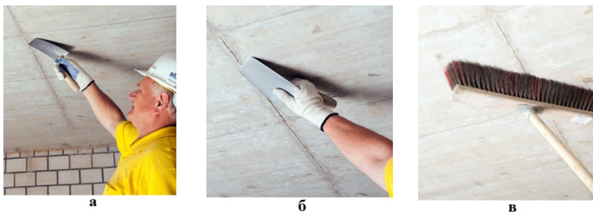
Рис. 4.85. Подготовка основания: а — проверка имеющихся перекрытий; б, в — удаление выступающих дефектов и пыли
