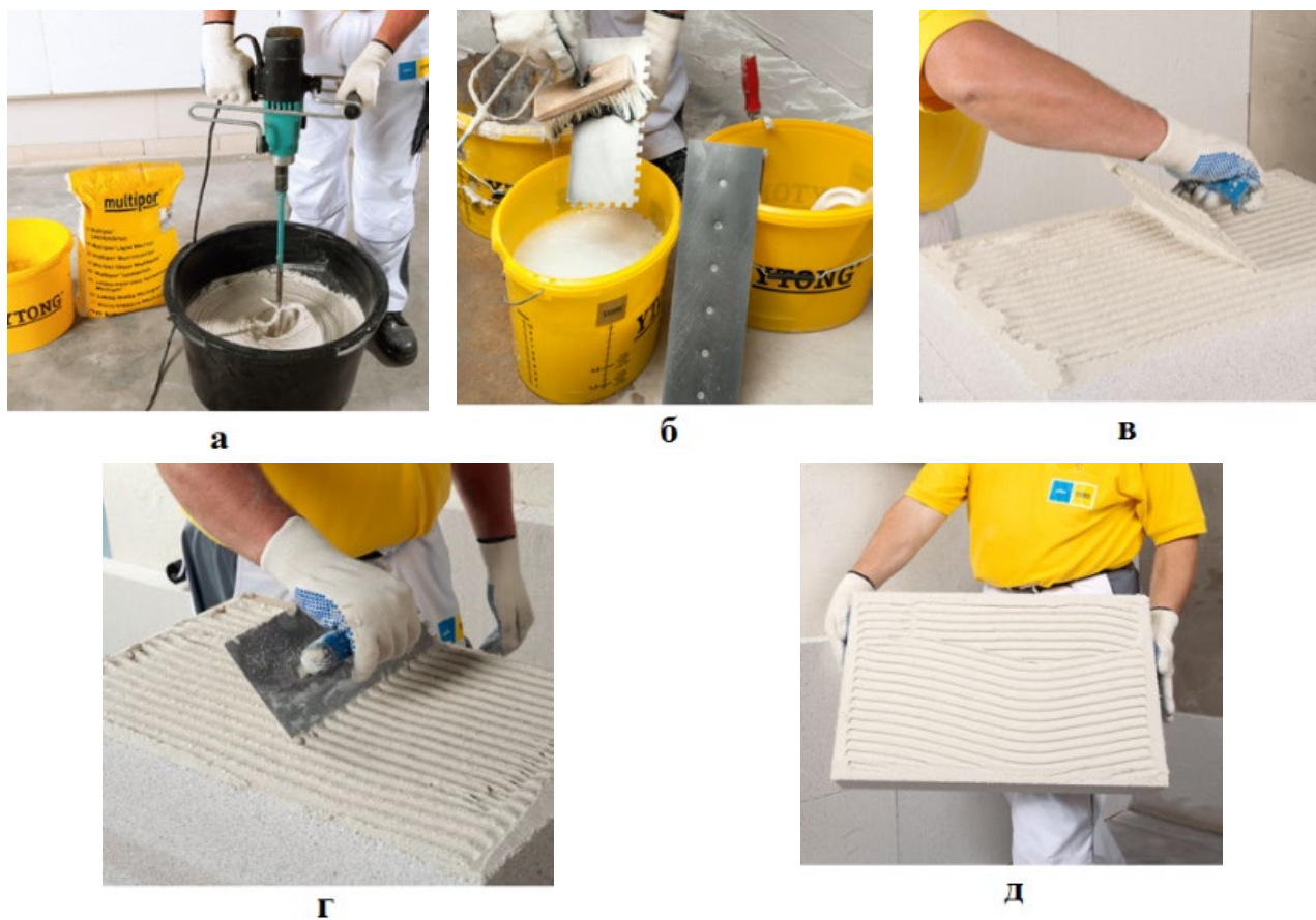
Рис. 4.56. Нанесение легкого раствора Multipor: а — приготовление раствора; б — очистка инструмента; в — нанесение легкого раствора; г — прочесывание легкого раствора; д — раствор, нанесенный на всю поверхность минеральной изоляционной плиты
