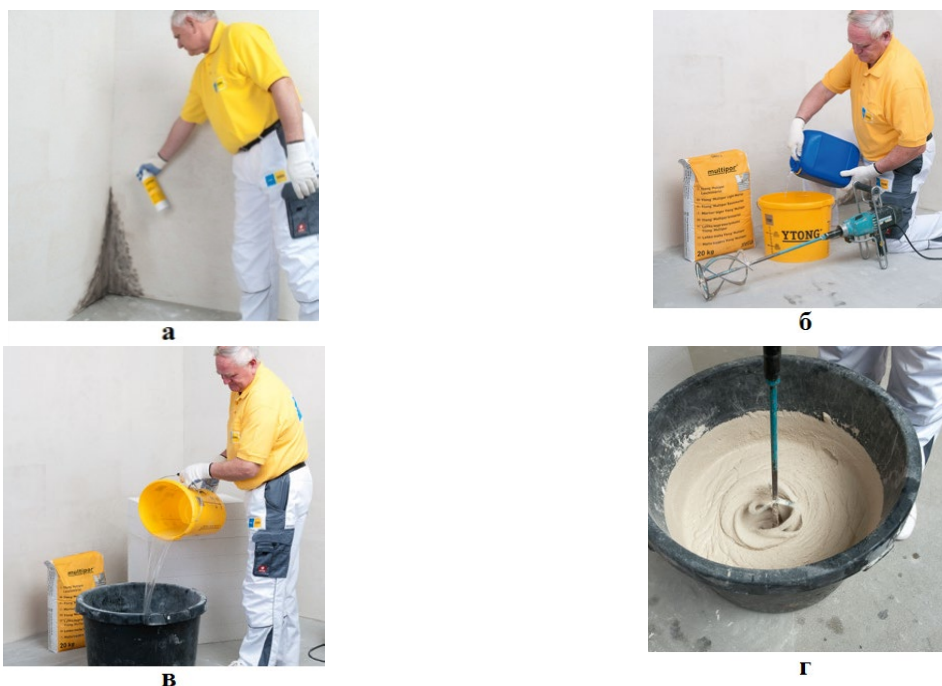
Рис. 4.71. Долговременная защита: а — обработка спреем; б, в, г — приготовление раствора
