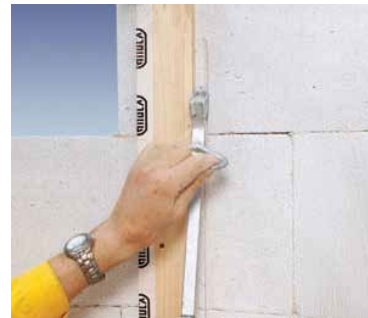
Рис. 3.77. Укладка дугообразных блоков: а — укладка первого ряда дугообразных блоков; б — армирование горизонтальных швов; в — о поверхности кладки шлифовальной доской; г — изготовление каналов для прокладки электропроводки
