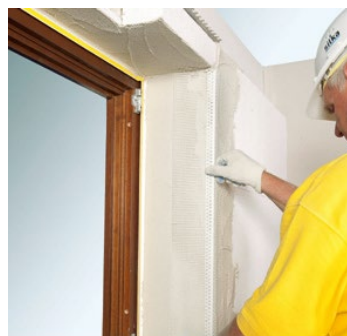
Рис. 4.61. Устройство откоса: а — установка плиты для откоса; б — установка углового перфорированного профиля
