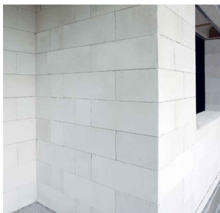
Рис. 3.10. Тонкошовная кладка
