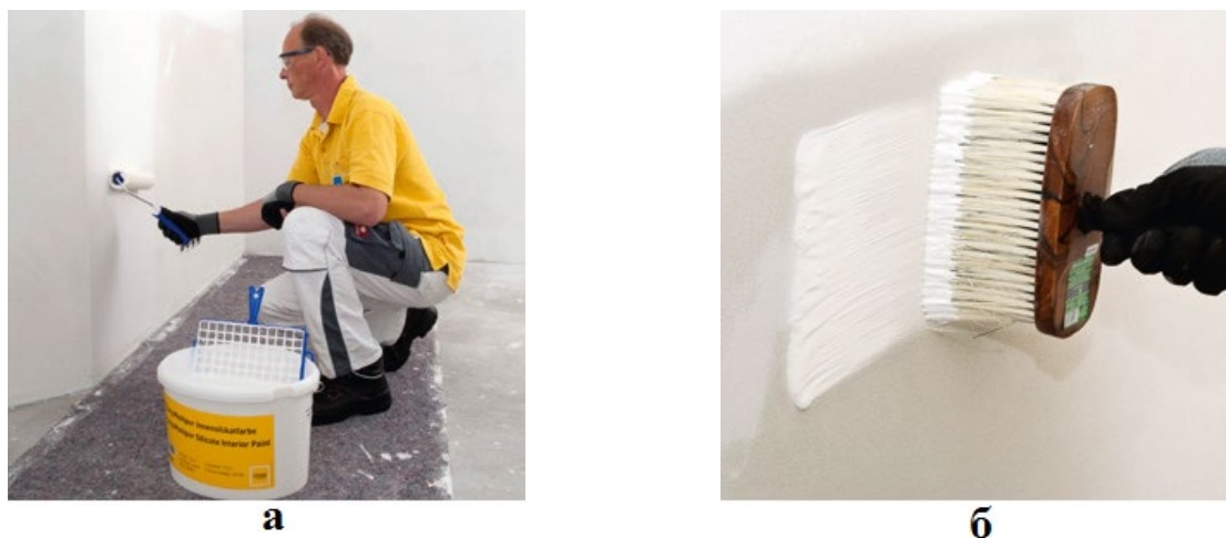
Рис. 4.59. Покрытие силикатной краской для внутренних работ: а — нанесение валиком; б — нанесение кистью
