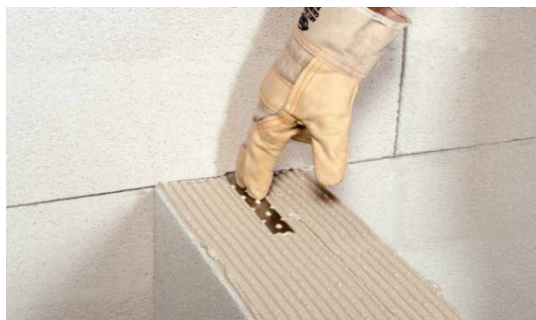
Рис. 3.86. Анкерное соединение
