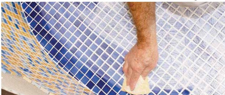
Рис. 3.78. Облицовка душа: а — нанесение влагостойкого грунтового покрытия; б — облицовка плиткой; в — затирка поверхности
