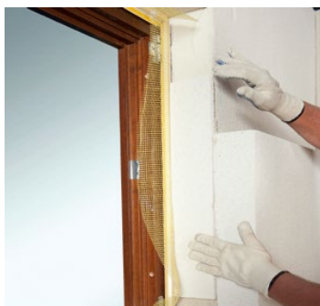
Рис. 4.61. Устройство откоса: а — установка плиты для откоса; б — установка углового перфорированного профиля
