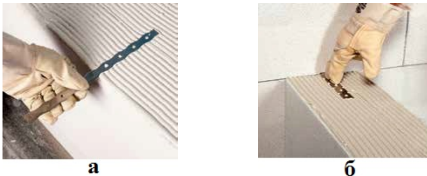
Рис. 3.71. Установка связей: а — закладка связи в шов; б — закладка связи в шов примыкающей стены
