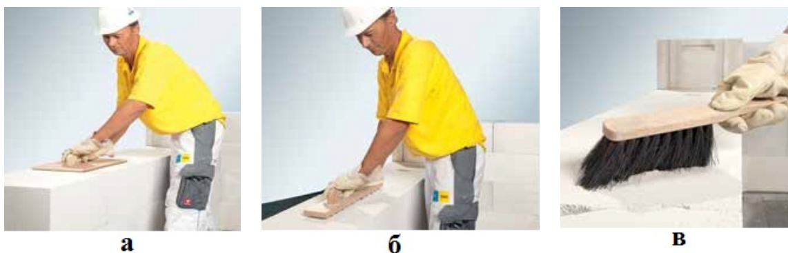
Рис. 3.66. Удаление неровностей кладки: а — выравнивание с использованием шлифовальной доски; б — шлифовка с использованием рубанка; в — удаление пыли и загрязнений при помощи щетки
