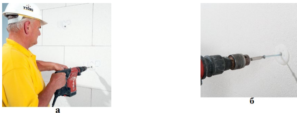
Рис. 4.48. Установка дюбелей: а — схема расположения дюбелей; б — крепление дюбелей
