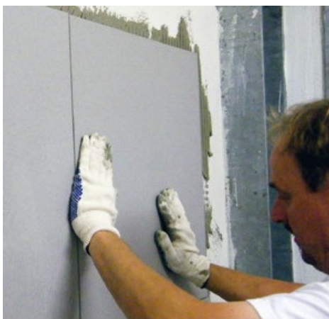
Рис. 4.60. Большие по размеру настенные кафельные плитки
