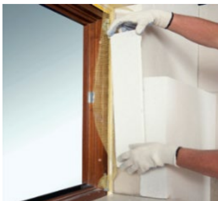
Рис. 4.3. Установка плит для откосов
