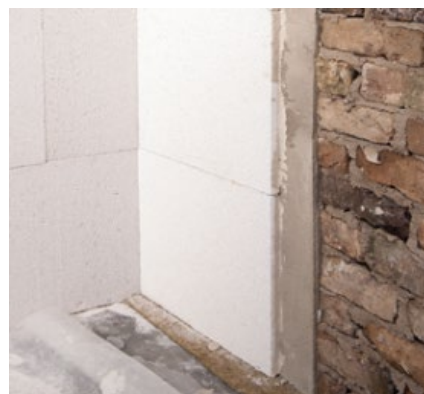
Рис. 4.4. Стыки стен с клиновидной плитой
