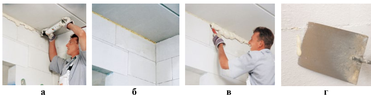
Рис. 3.91. Герметизация швов: а — заполнение швов; б — готовый эластичный верхний монтажный шов; в — отделение кельмой выступающей и отвердевшей монтажной пены; г — отделение ножом выступающей и отвердевшей монтажной пены
