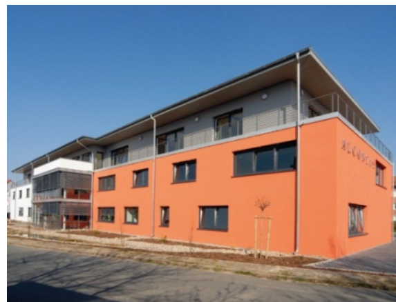
Рис. 4.37. Здание с энергоэффективной кровлей
