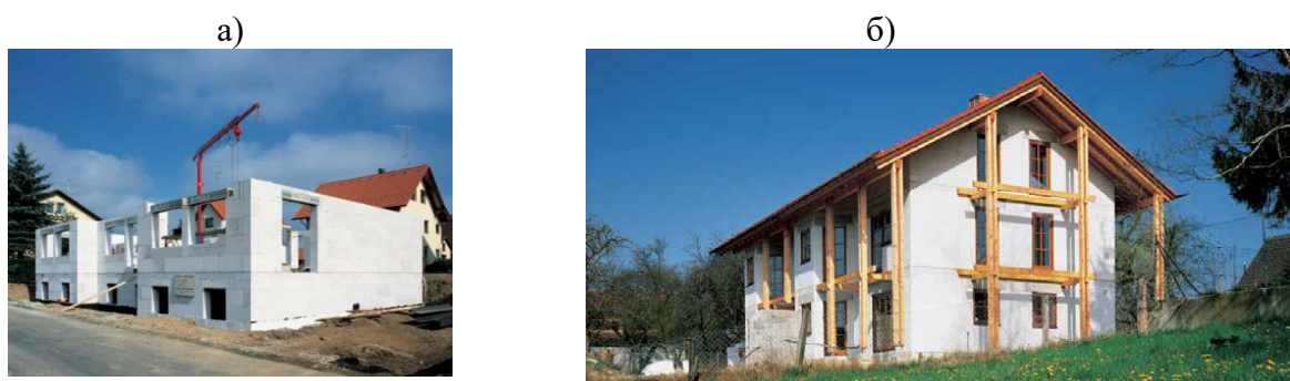
Рис. 1.6. Коттеджи из газобетона YTONG: а – кладка стен; б – финишная отделка
