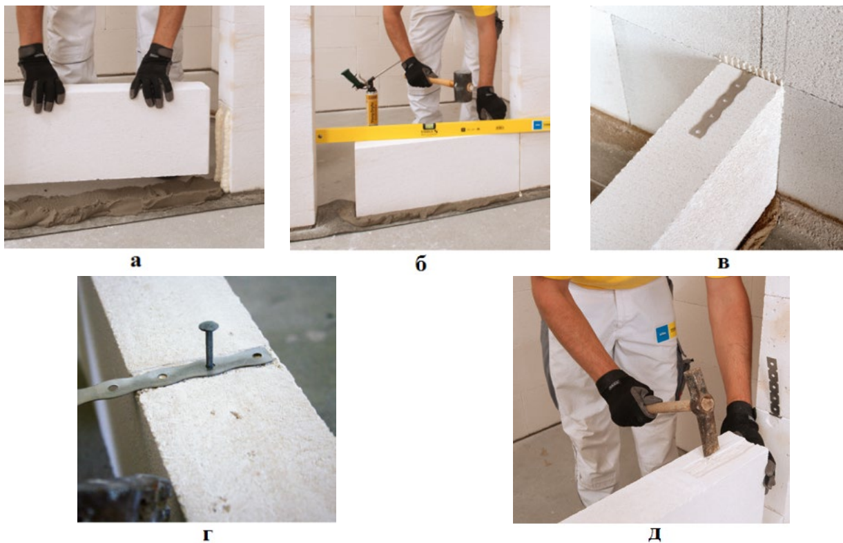
Рис. 3.88. Укладка первого ряда: а — нанесение нормального слоя раствора; б — вертикальное исполнение при помощи уровня; в — связь кладки загибают по горизонтальному шву кладки; г — фиксация кладочного анкера; д — точная по размеру выемка в блоке в зоне кладочного анкера
