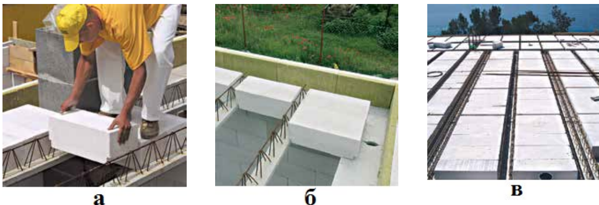
Рис. 3.83. Монтаж Т-образных блоков перекрытия: а — укладка первого блока; б — укладка блока-вкладыша; в — уложенные в перекрытие блоки
