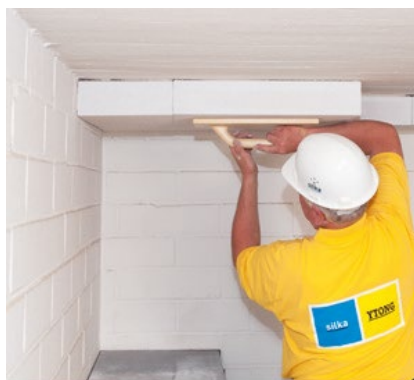
Рис. 4.40. Простое клеевое крепление при имеющемся перекрытии
