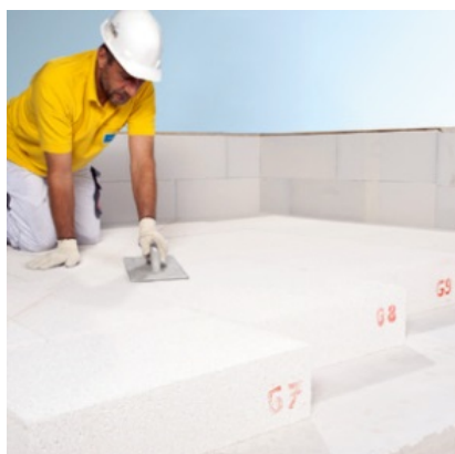
Рис. 4.75. Укладка плиты под уклон
