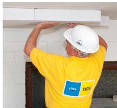
Рис. 4.40. Простое клеевое крепление при имеющемся перекрытии
