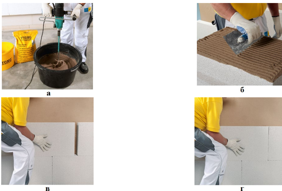
Рис. 4.65. Монтаж плит в системе с использованием глины: а — перемешивание глиняного раствора; б — «расчесывание» глиняного раствора; в — установка плит скользящим движением по стене; г — фиксация (прижатие) плит
