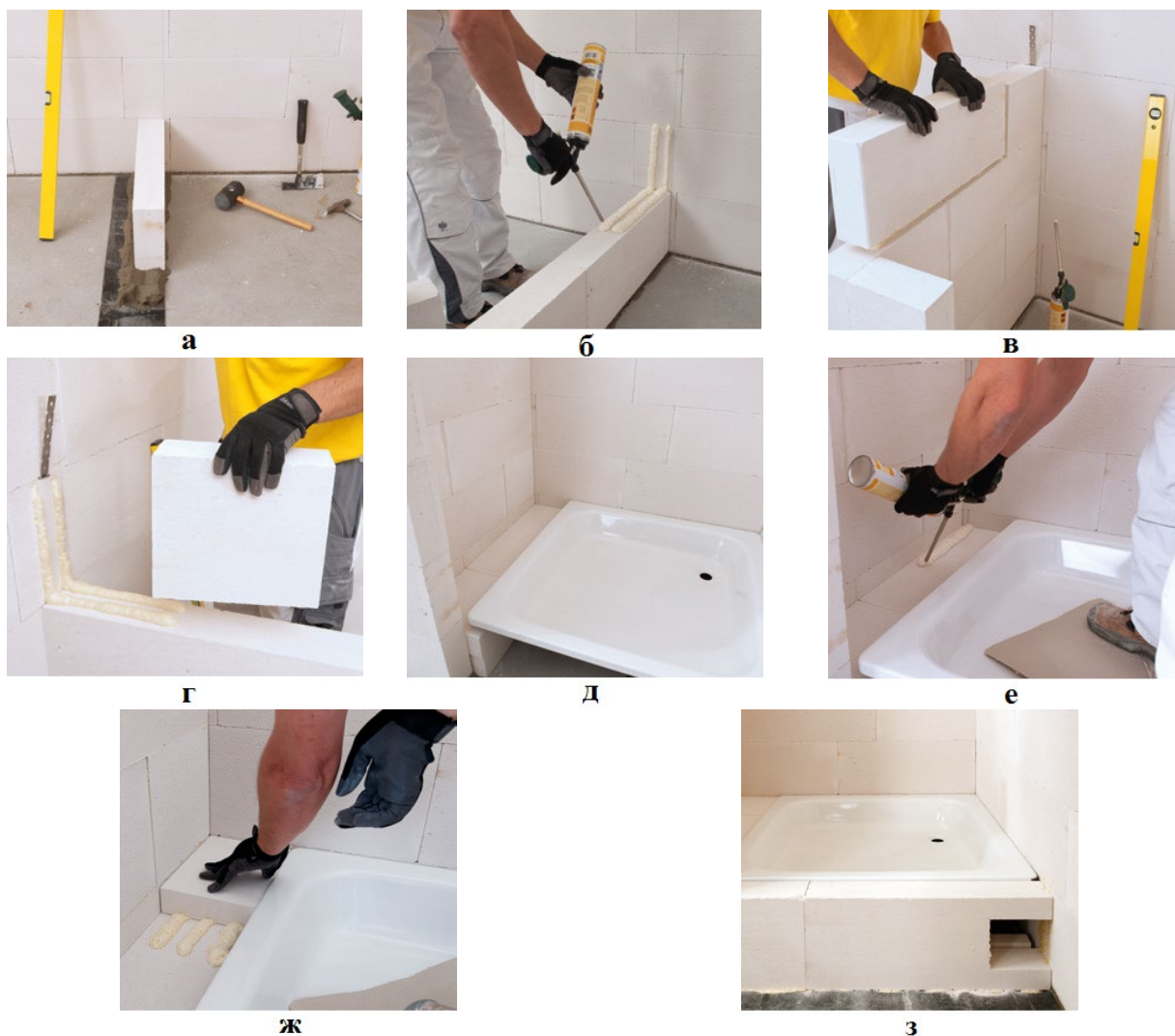
Рис. 3.92. Выполнение ограждений: а — возведение стены для отделения душевой; б — монтаж плоских плит в горизонтальных и вертикальных швах; в — послойная укладка; г — боковые соединения стен с кладочными соединителями; д — установка поддона для душа; е — защита поверхностей путем подкладывания изоляционного картона; ж — монтаж плит в качестве платформы; з — отверстие в кладке для ревизии
