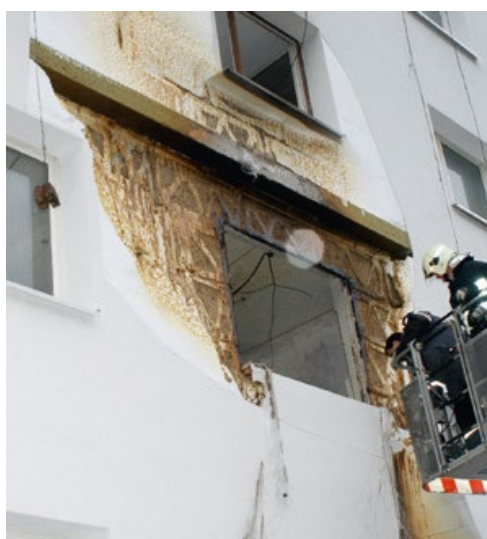
Рис. 4.28. Комбинированные системы теплоизоляции с горючими составными частями от одного производителя
