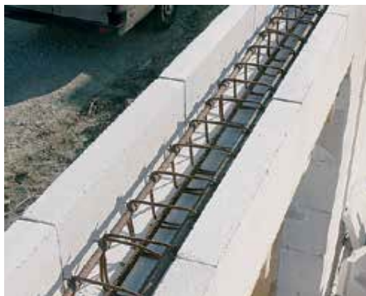
Рис. 3.6. Правильно подготовленная перед бетонированием перемычка из U-образных блоков YTONG
