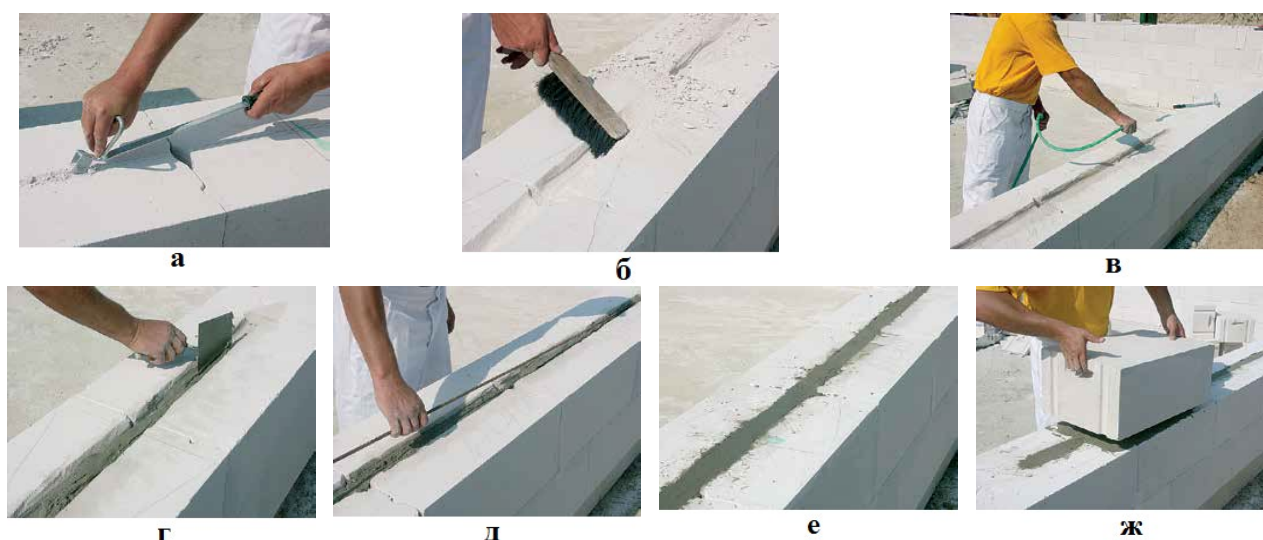
Рис. 3.73. Армирование под оконным проемом: а, б — штробирование пазов и удаление пыли; в — увлажнение паза; г — частичное заполнение паза раствором; д — укладка арматуры; е — заполнение паза раствором; ж — укладка следующего ряда блоков
