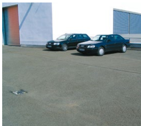
Рис. 4.33. Автостоянка на крыше
