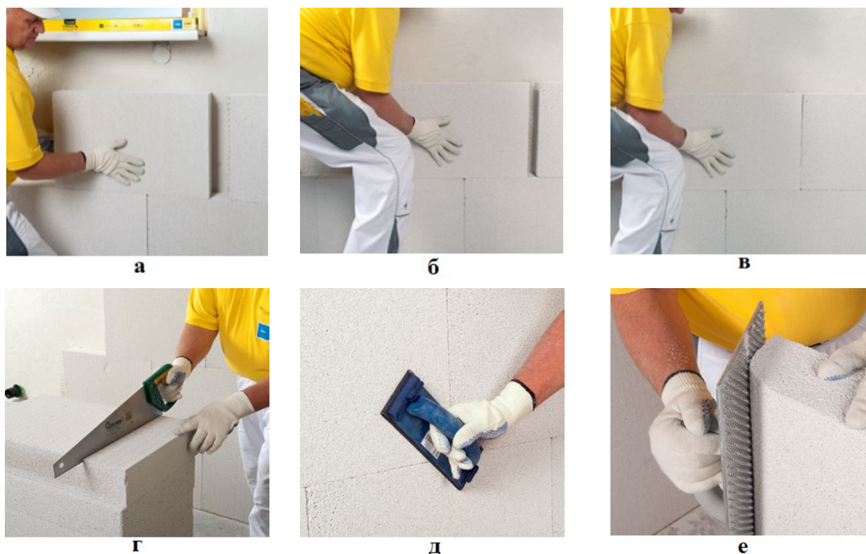
Рис. 4.57. Монтаж плиты: а — прикрепление; б — прижатие скользящим движением; в — стык и горизонтальный шов кладки имеют прочное соединение; г — обрезка плиты до нужного размера; д — притирка неровностей; е — обработка закруглений
