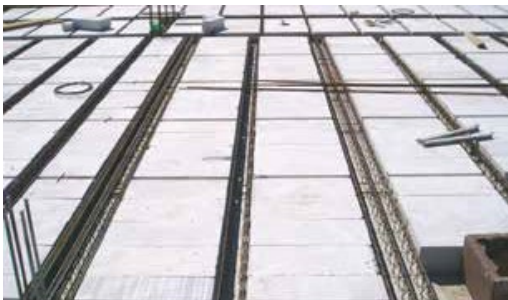
Рис. 3.7. Сборно-монолитное перекрытие YTONG
