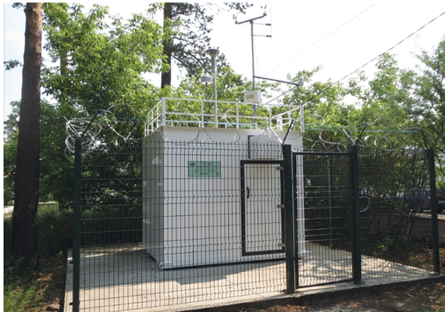
Рис. 3.5. Стационарный павильон станции мониторинга атмосферного воздуха МР-28
