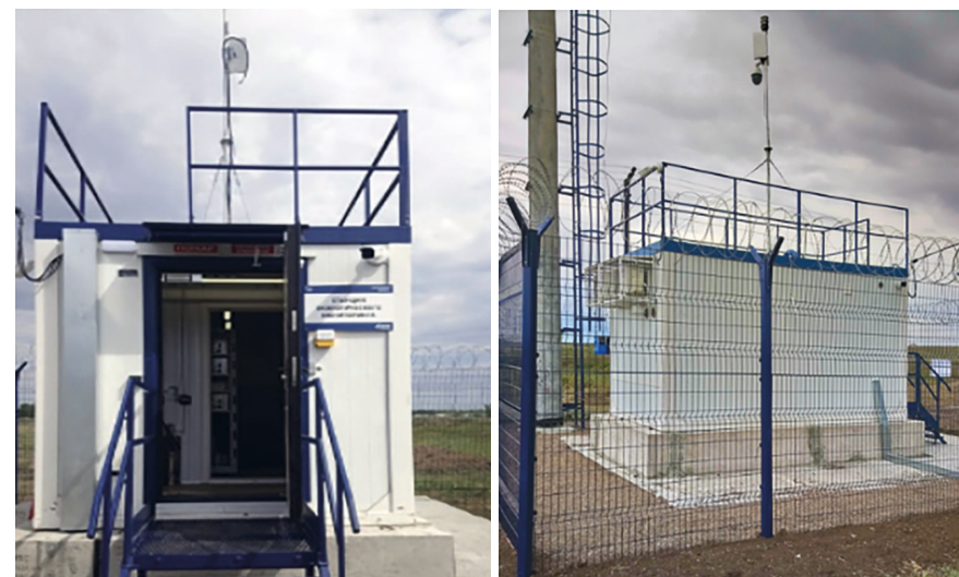
Рис. 3.1. Стационарный павильон станции мониторинга атмосферного воздуха СЛАВ
