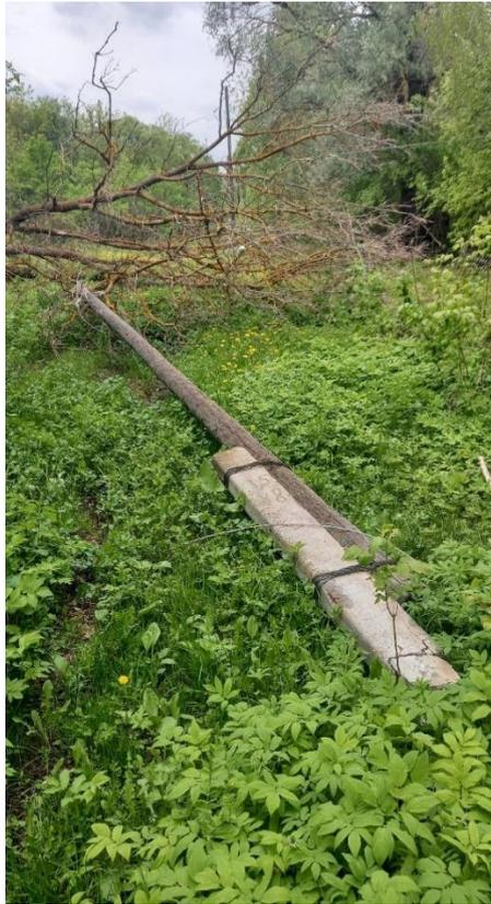
**Рис. 1 Разрушение опоры ВЛЭП упавшим деревом**
